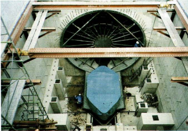
ケーシング裾付状況
