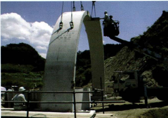
プレキャスト部材裾付状況
