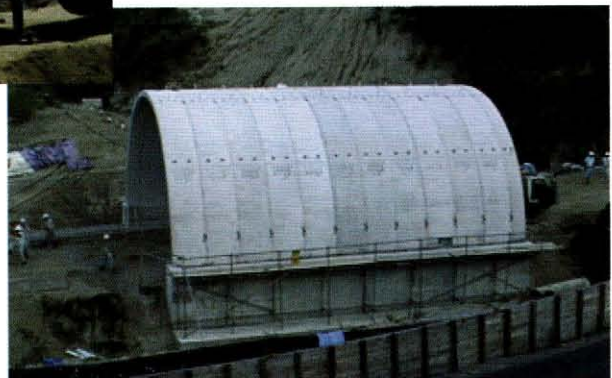
プレキャスト部材裾付完成状況
