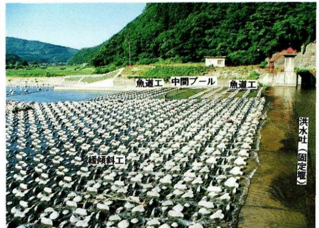
改修後の魚道 (左岸より)
