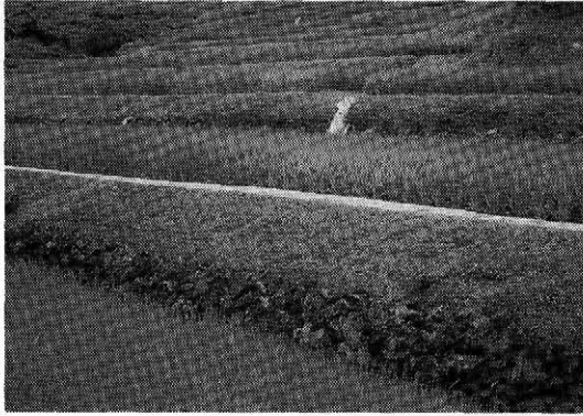
写真-2 棚田畦畔の法面構造
