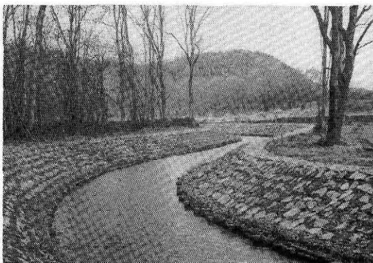
①施工後約3ヶ月後の状況
