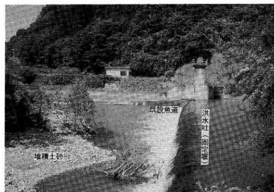
写真—1 魚道改修前状況 左岸より
