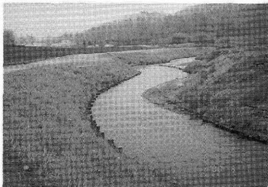
③路線線形により発生した中州
