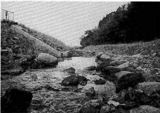
写真一 取水堰現況写真
