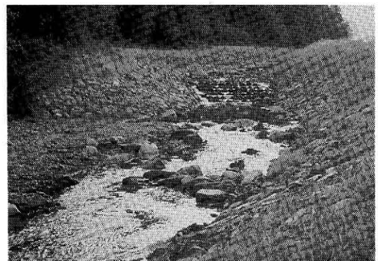
写真—5 自然落差工下流部の水の流れ
