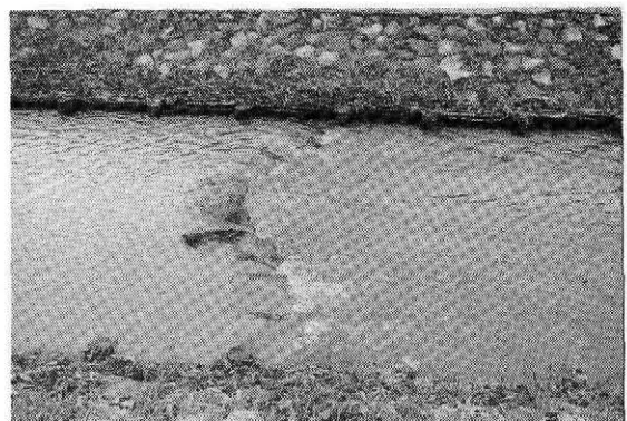
②自然石による段差工
