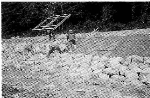
写真—4 護岸工施工状況
