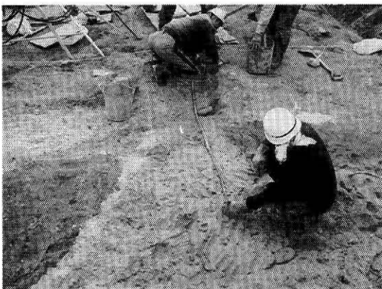
写真-2 コアトレンチ内の電極敷設状況
