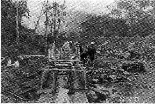
写真—5 「現場適用技術」を農家自ら駆使して型枠を設置 (1999年2月)
