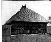
農業集落排水処理施設
