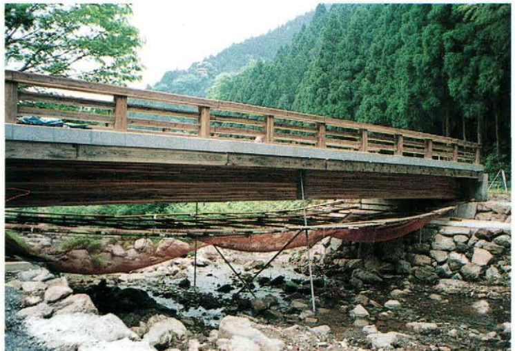
杉の木一号橋の完成写真
