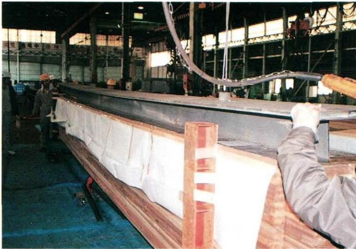
主桁への下鋼板の装着
