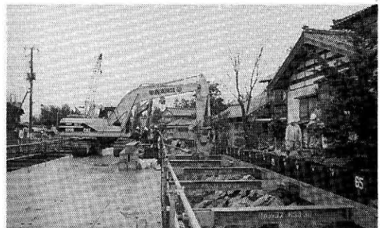
写真-2 住宅近接地の作業状況（仮設構台上から旧護岸の取り壊し）
