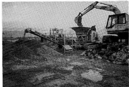
写真-4 自走式破砕機にガラを投入しRC-40を生産している作業状況
