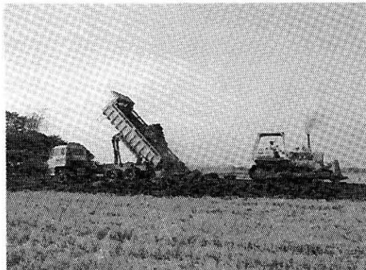
施工中のDitch and Dike事業
