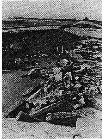
写真二 溢流堤の残骸
