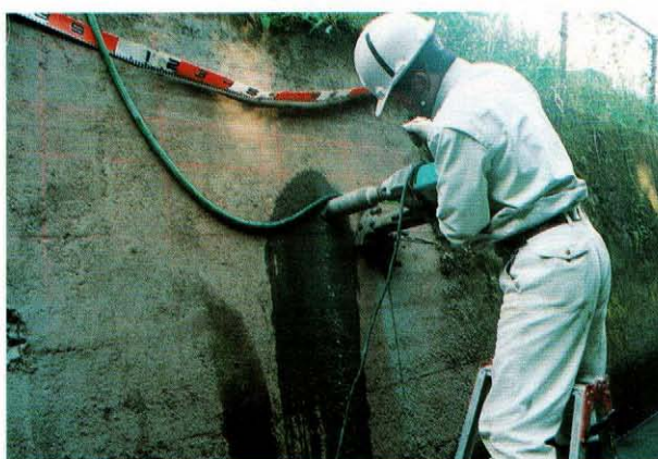
劣化状況調査(コンクリートコア採取状況)
