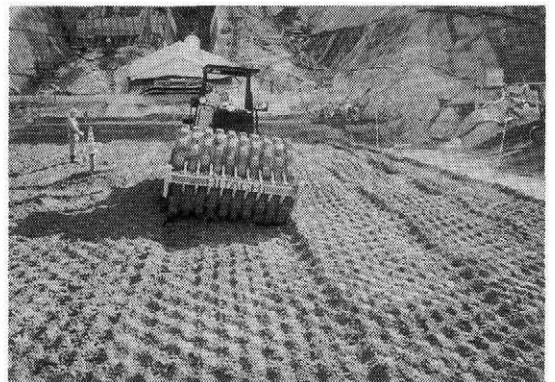
写真-1 ウェービング発生状況(平成9年度)
