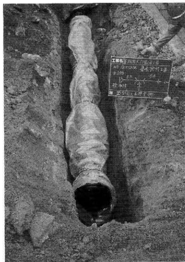
写真-2 集水管（ポリエチレンスリーブ被覆）埋設状況
