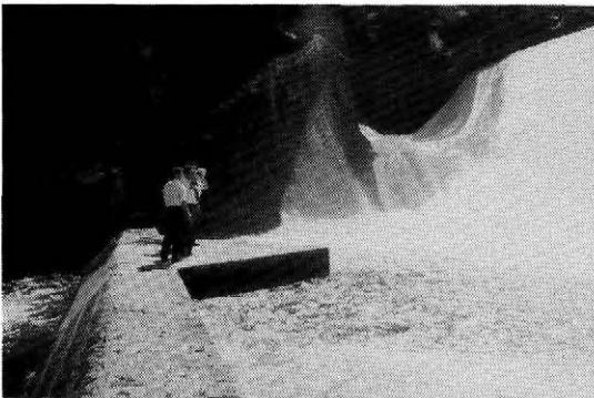
写真-5 右岸は「武者返し」の造形により水が堰堤をなだらかに円弧を描いて落ちていく下流の地盤が弱いため水が急速に落ちないように工夫されている。
