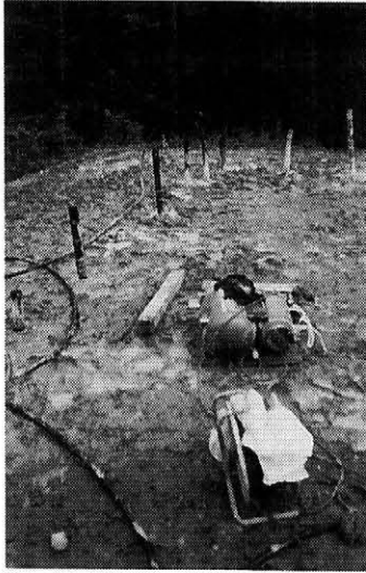
写真一—二 超微粒子セメント系注入材の注入状況
