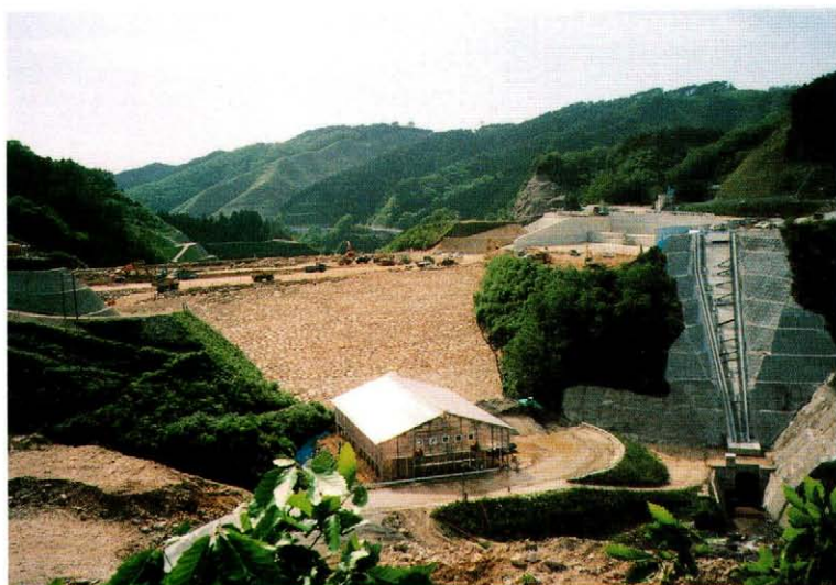
堤体及び遮水材乾燥設備の全景(上流側より)
