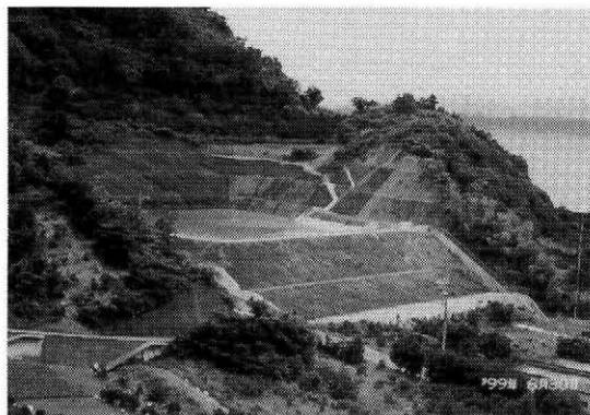
写真-3 貯水池全景
