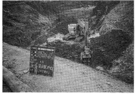
地盤改良工 施工状況
