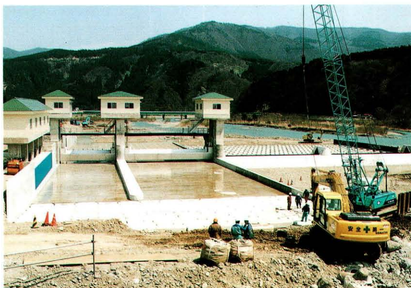
平成10年度工事完成写真 〈全景〉
