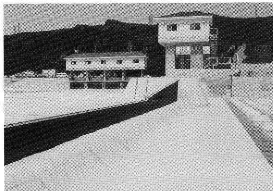
写真—4 ゴム堰（倒伏時）
