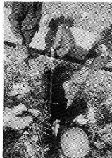
排水孔の設置(写真-2-4)
