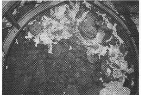
写真一八 ウレタン注入断面詳細
