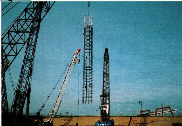
鉄筋かご吊り込み状況
