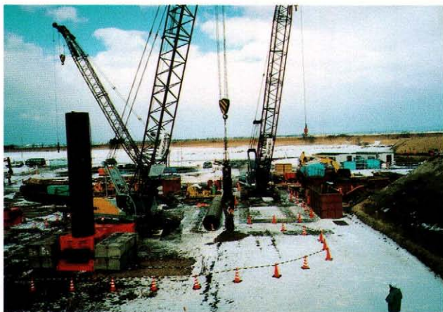
スタンドパイプ建込み ハンマーグラブ中掘状況
