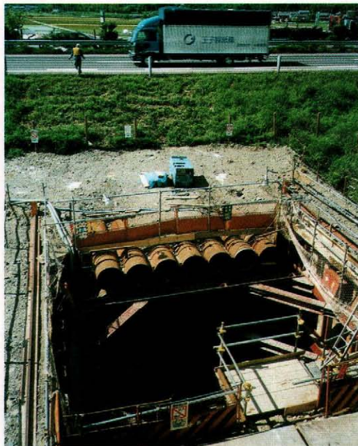
パイプルーフ施工状況
