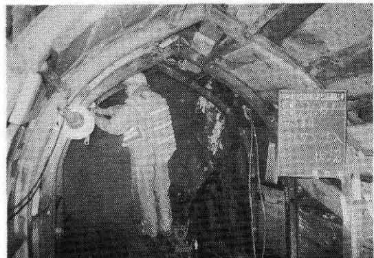
写真-4 ウレタン注入
