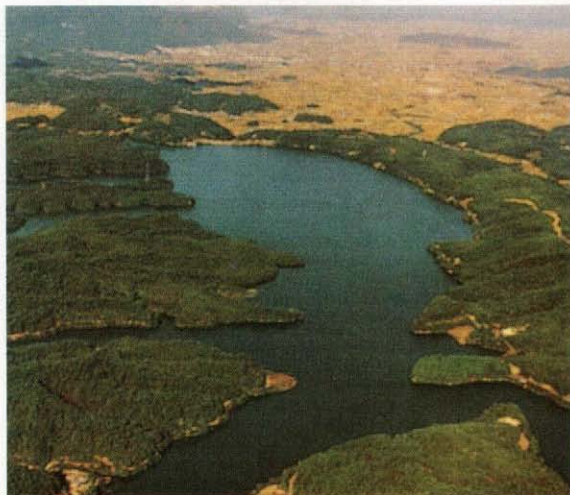
白鳳時代に築造された満濃池は幾多の補修を行い現在の形になっている
