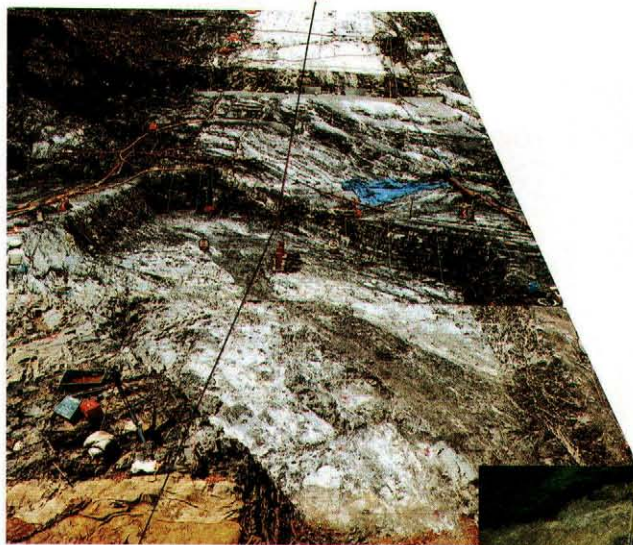
断層処理部の掘削全景
