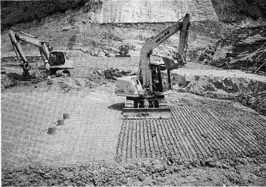
写真—2 コントクトコアレーキ処理
