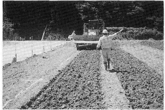
写真一1 転圧状況
