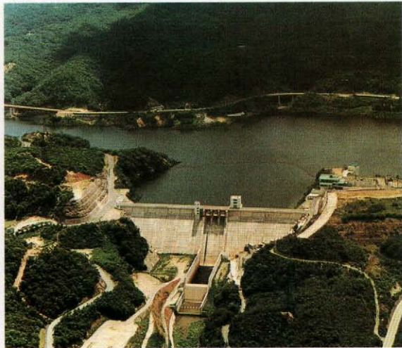
竣工した呑吐ダム
