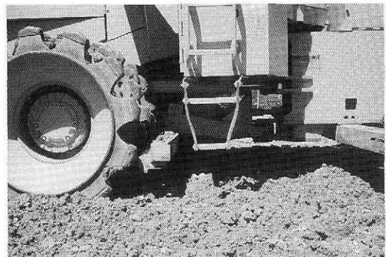
写真一3 転圧状況
