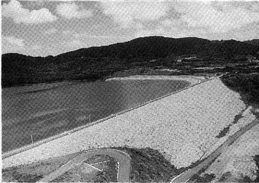
写真—4 試験湛水中の名蔵ダム（沖縄県，H=38.7 m，V=3,970千 m^3 ）
