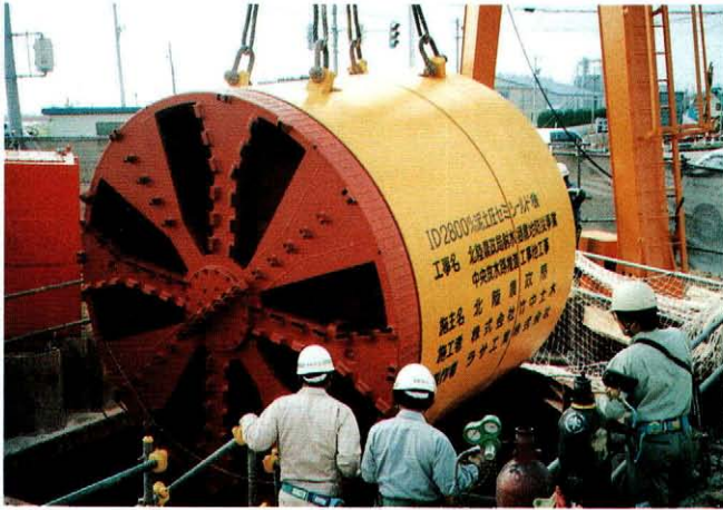
推進機を立坑に降ろす。
