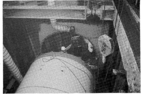
写真一 2 H9 10/27～28 発進立坑鏡切り
