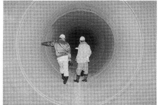
写真一七 推進管内部の出来高確認
