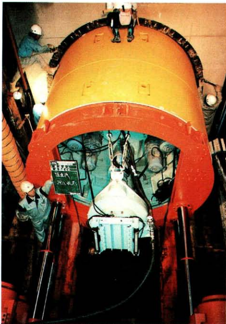
推進機押し込み状況（ゲージで確認）
