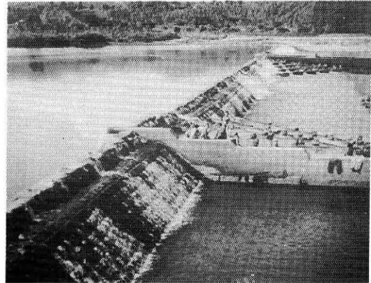
旧井堰（昭和10年3月完成）
