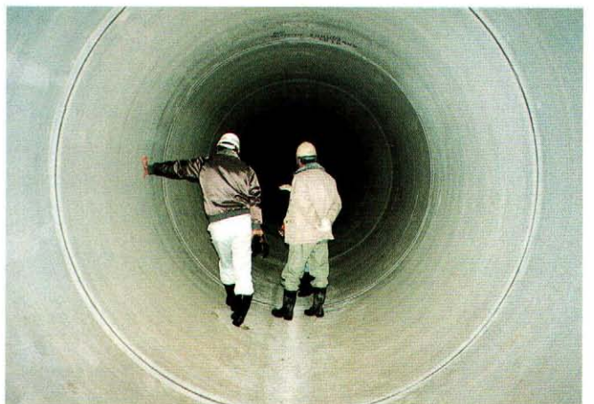
推進管内部の出来高確認
