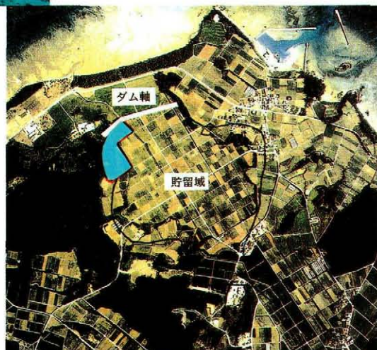
伊是名地区の整備された農地と 基幹水源となる千原地下ダムサイト(上空より)
