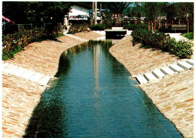
親水ゾーンにおける 新鉄平石を用いた緩傾斜護岸水路
