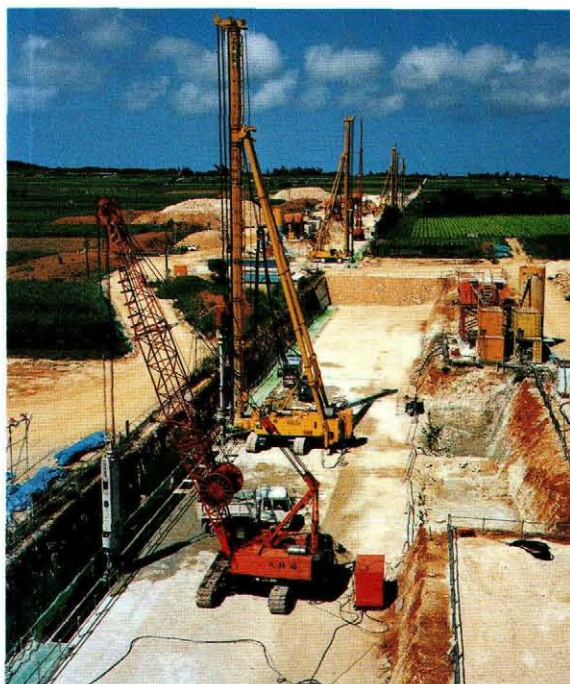
世界最大の宮古地下ダム (止水壁)の建設状況
