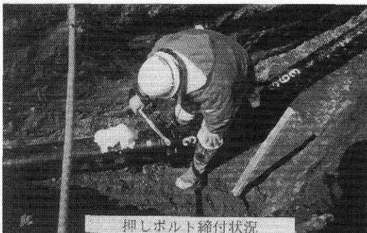
押しボルト締付け状況
