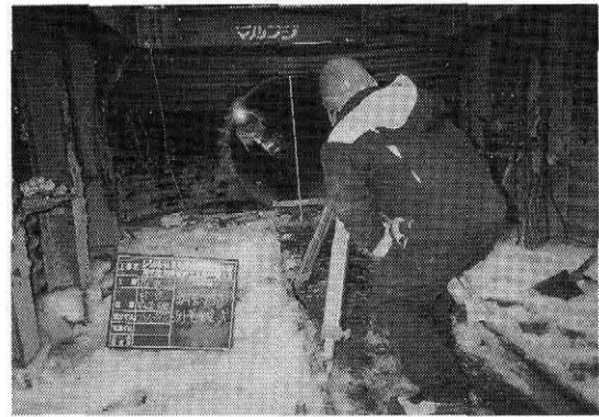
写真—5 到達坑に貫通した状況 (後に本管DCIP \phi 1,000\text{mm} を挿入する。)
