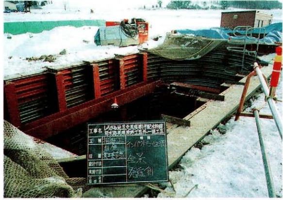
発進坑 (仮設は立坑と コンプレッサーのみ)
