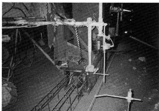
写真—5 コンクリート打設
