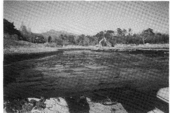
掘削終了状況
