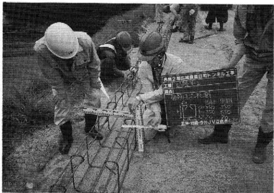
写真—3 鉄筋組立 (配筋検査)
