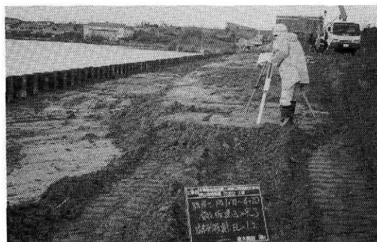
写真二 施工前天端高確認検査
