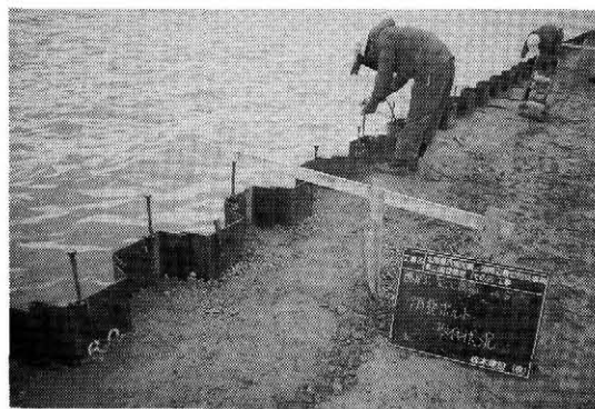
写真四 高さ調整ボルト用ナット取り付け
