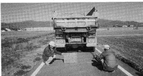
写真-4 ベンケルマンビーム試験状況
