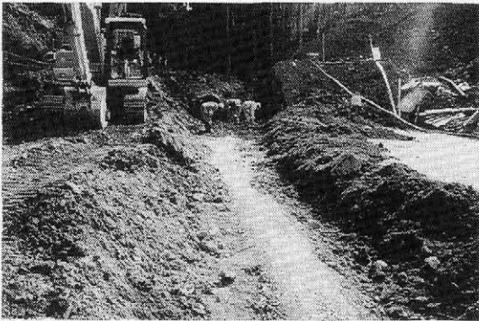
写真一 床均し状況
