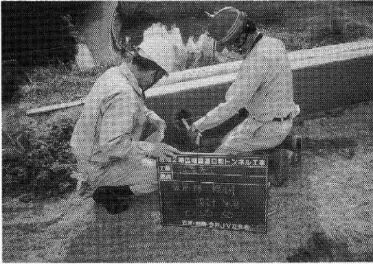
写真—9 鉄筋のかぶり確認
