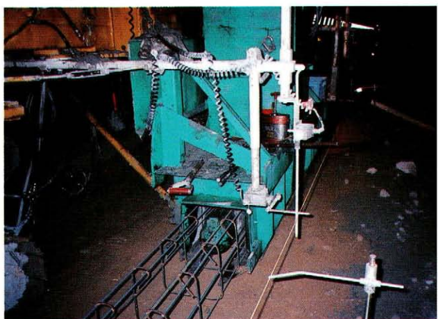
コンクリート打設中のモールド
