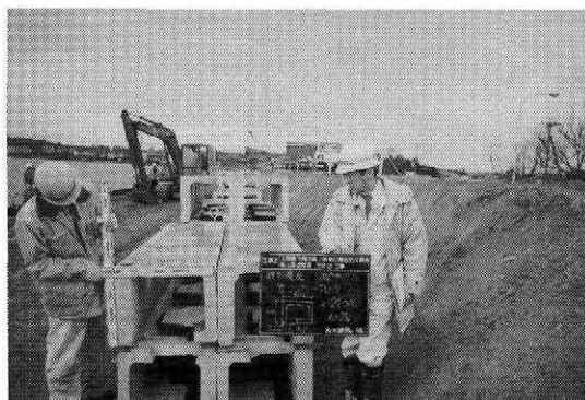
写真一 笠コンクリート受入検査
