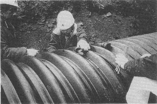
写真一6 設置状況③
