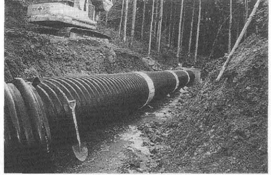
写真一9 敷設完了
