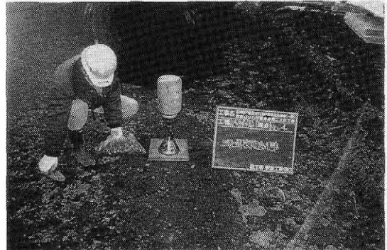
写真三 現場密度試験
