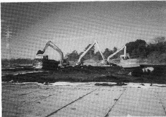
普通バックホウダンプトラック積み込み状況
