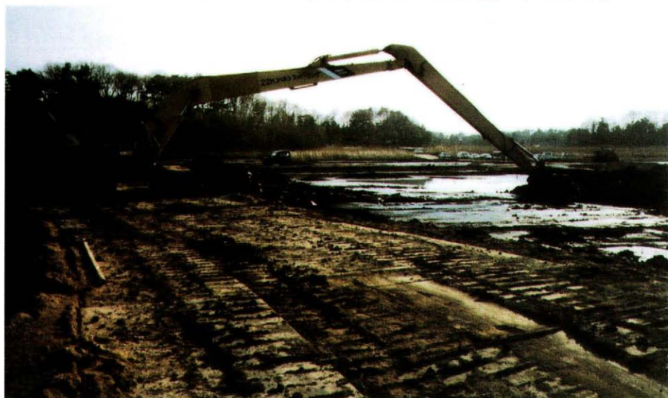
スーパーロングアームタイプの BH掘削状況
