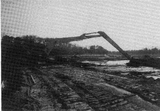
SLBH掘削状況
