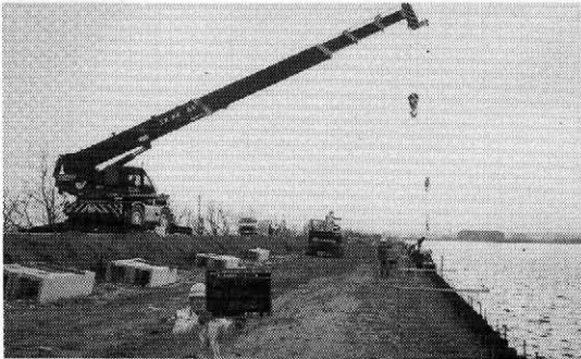
写真一七 笠コン据付け
