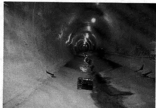
写真六 2次覆工完成
