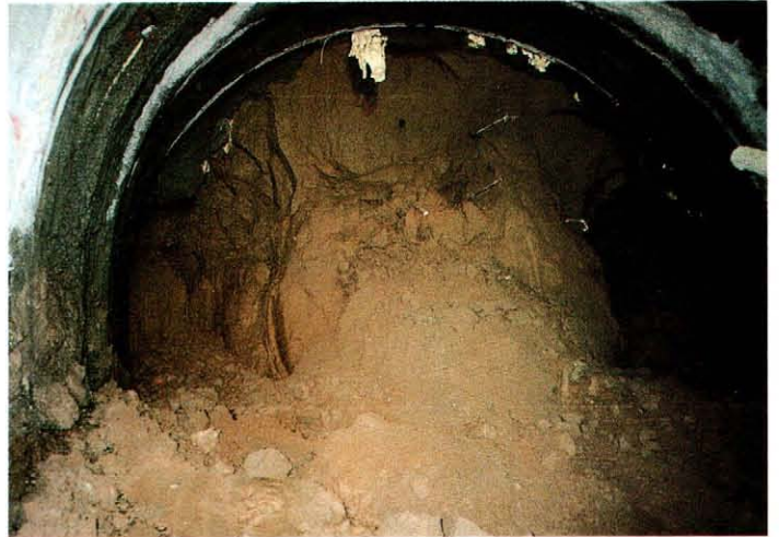
小田ダム (仮排水トンネル) (本文68頁)
