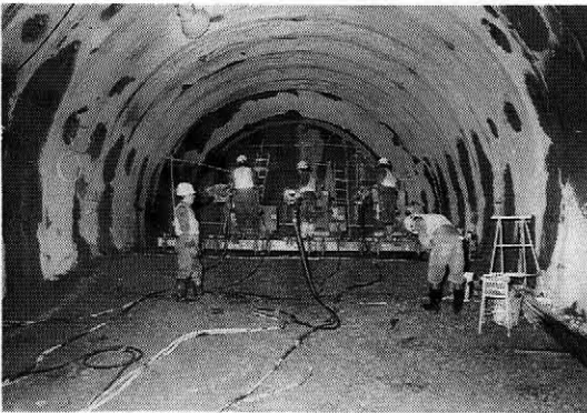
写真五 薬液注入状況
