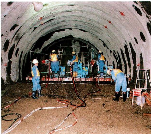
薬液注入状況
