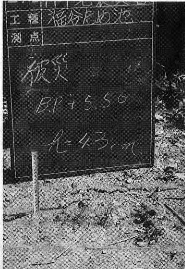
写真② 堤頂部縦断亀裂状況
