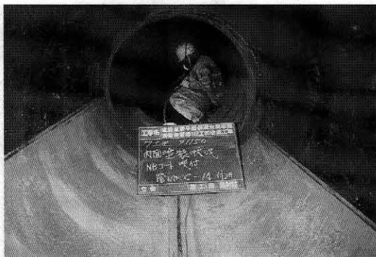
写真—17 塗装状況 (管内)
