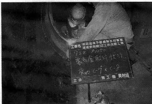
写真一五 裏当座金取付状況 (円周方向にセット)
