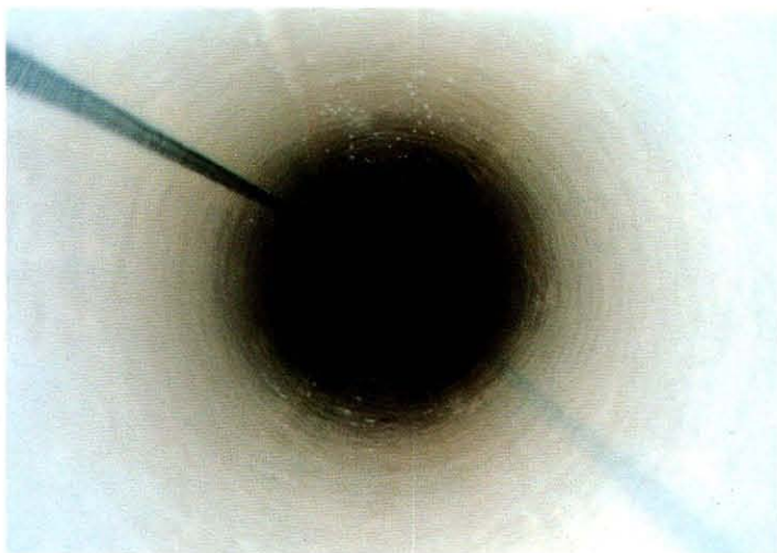
INS工法施工後 (ヒューム管内部)
