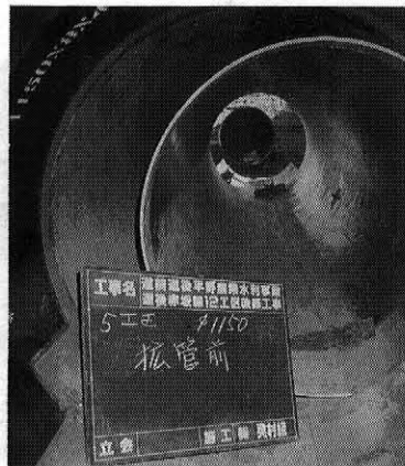
写真—2 管内セット状況 (拡張前)
