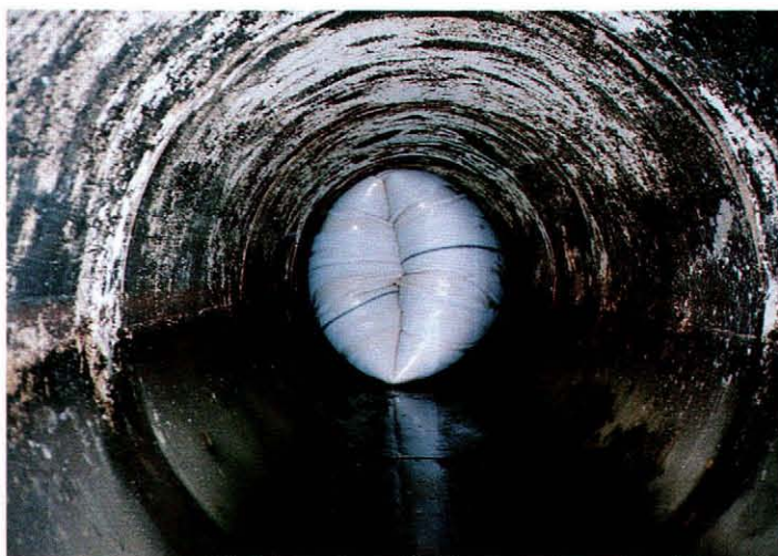
INS工法施工中 (ヒューム管内部)
