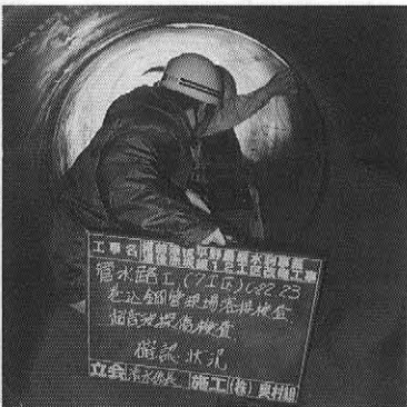
写真一一 溶接力所，検査状況 (超音波深傷検査)
