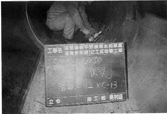
写真一三 掘管状況 ジャッキアップ
