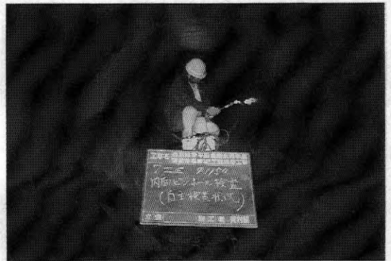
写真—19 ピンホール, 自主検査
