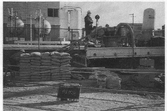
写真一三 裏込め工泥練り状況
