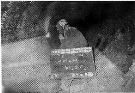
写真—16 グラウトホール閉塞, 溶接状況
