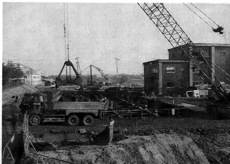
写真一4 増設機場施工(掘削)
