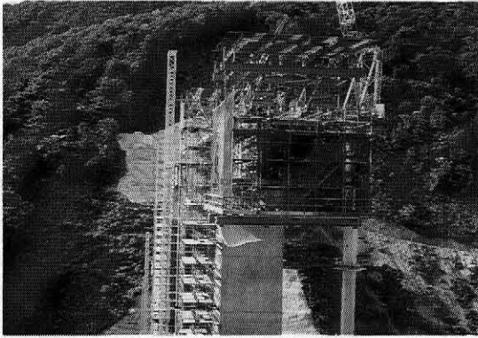
写真-3 ワーゲン施工状況
