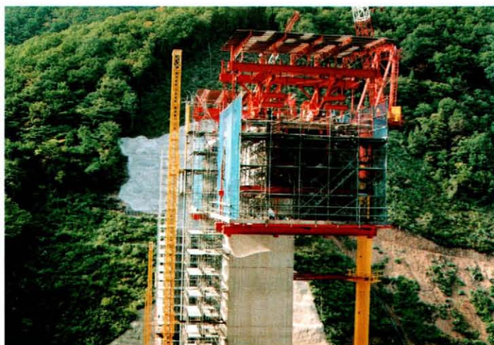
ワーゲン施工状況
