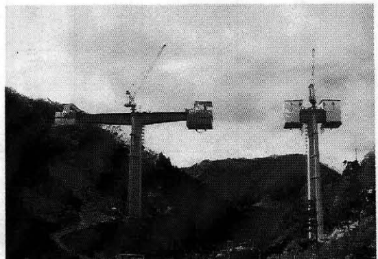
写真-1 榎谷ダム第5号橋梁全景
