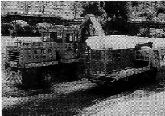
写真一 5 雪の詰め込み作業 (平成8年度)
