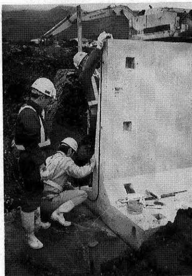
写真一 10 水膨潤性ゴムの張り付け
