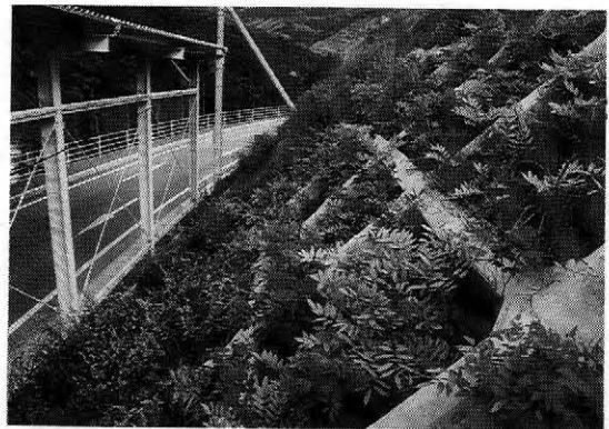
写真-6 施工事例3 花木主体ののり面緑化の試み
