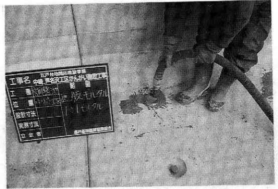
写真一七 ブロック底面へのグラウト注入
