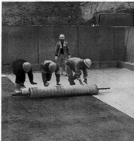
写真-16 ベントナイトマット敷設
