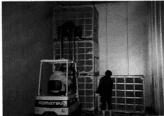
写真一 6 メッシュコンテナの設置作業
