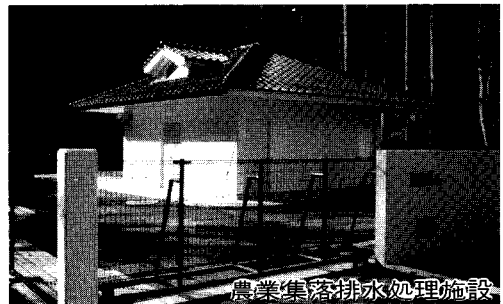
農業集落排水処理施設
