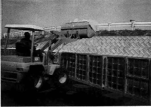
写真一 4 雪の詰め込み作業 (平成7年度)
