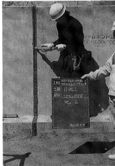
写真-15 弾性エポキシシーリング材の充填
