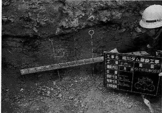
地盤改良後の状況
