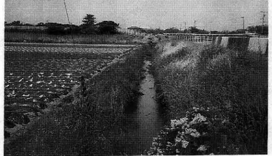
写真—3 地区内用排水路
