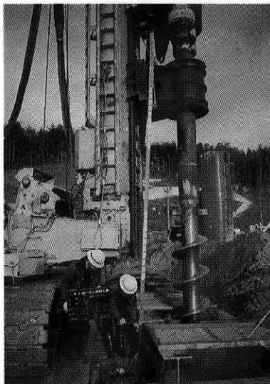
先行削孔（検尺）
