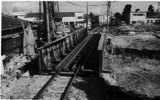
写真一 3 工事桁の設置
