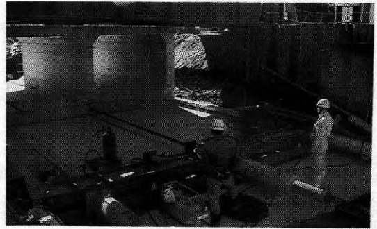
写真一 6 フロンテジャッキによるけん引
