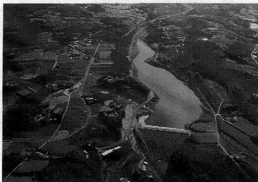
久吹ダムの全景
