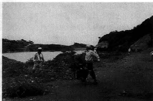
写真一三 久吹ダムにおける除草作業
