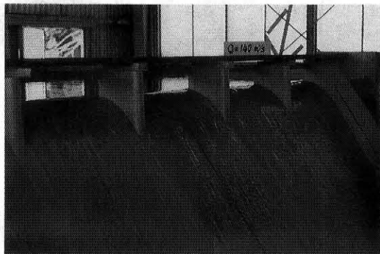
1. 設計流量 ( Q=140\text{m}^3/\text{s} ), 越流部の流況
