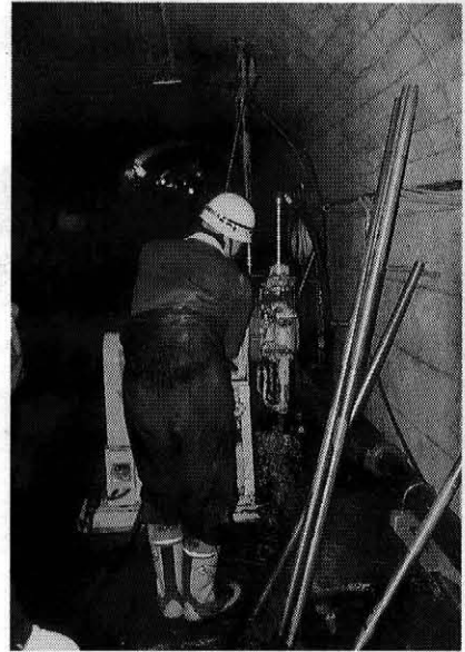
写真-2 ボーリング作業状況
