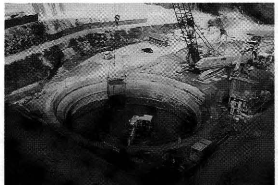
写真-2 掘削・ズリ出し
