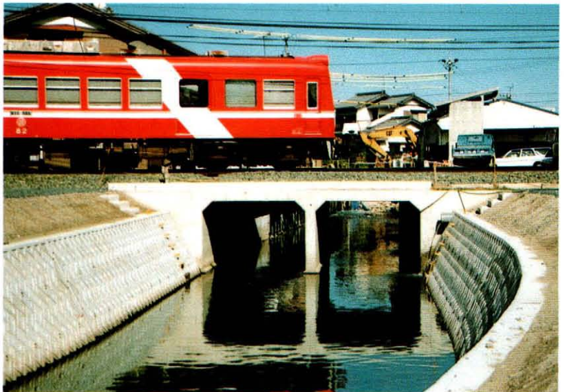
完成した鉄道横断暗渠（本文37頁）
