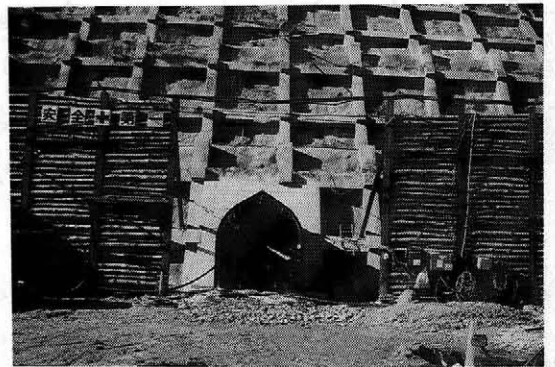
写真-3 リムトンネル入口
