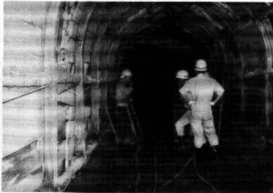
写真-1 リムトンネル掘削状況
