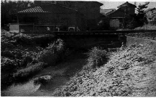
写真一 1 施工前
