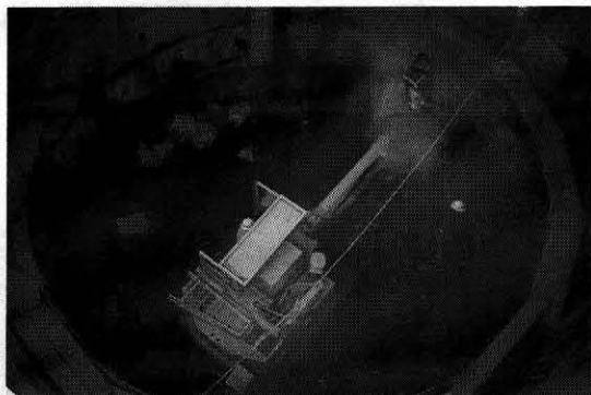
写真-1 発破掘削 (クローラドリルによる穿孔)
