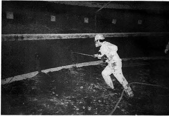
写真一五 ロックボルト工（ロックボルトの挿入）
