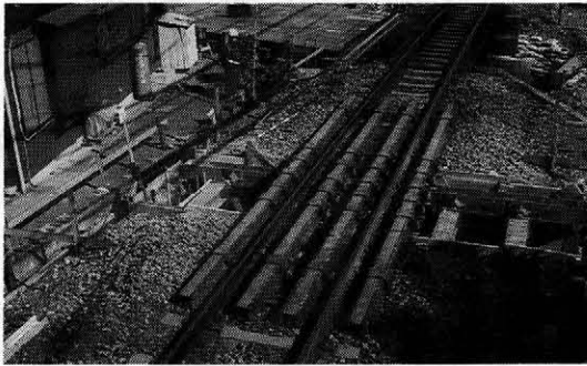
写真一 2 軌条桁の架設完了
