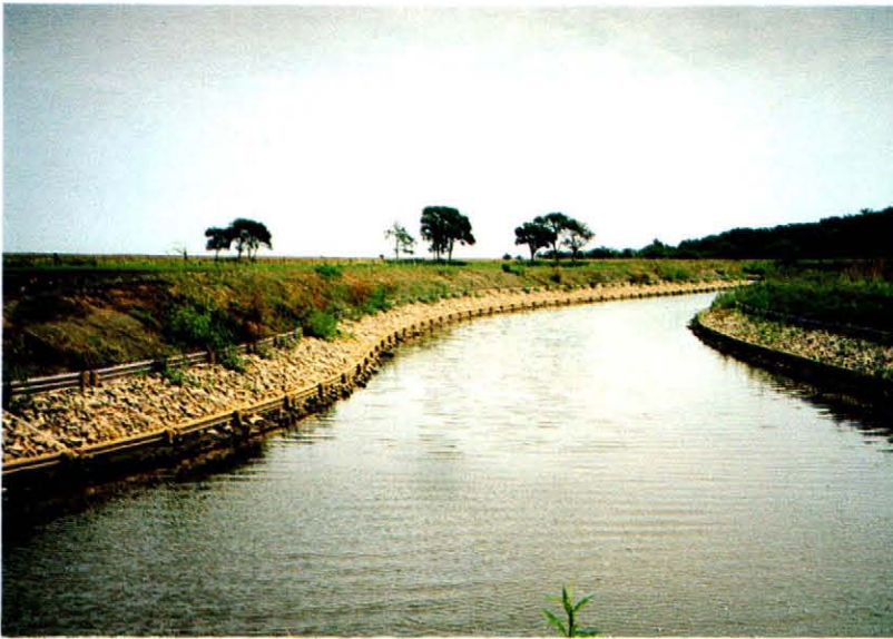
完成した八十土排水路（本文2頁）
