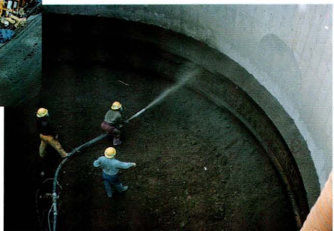
2次吹付コンクリート (本文47頁)
