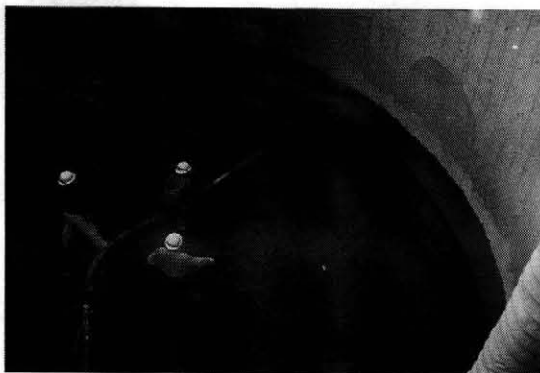
写真一三 2次吹付コンクリート
