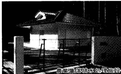
農業集落排水処理施設 (鳥取県淀江町本宮処理場)
