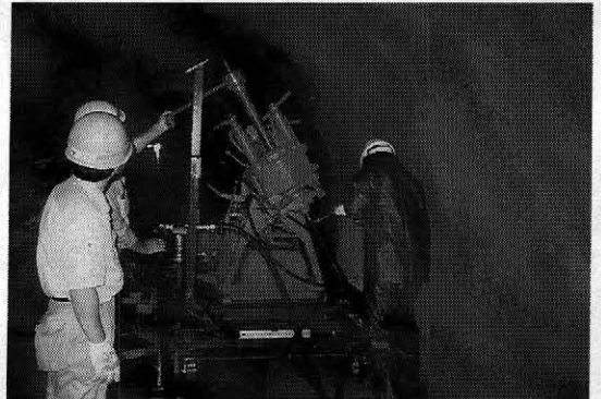
写真—6 水抜きボーリング
