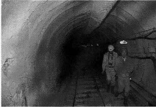
写真—5 トンネル内面
