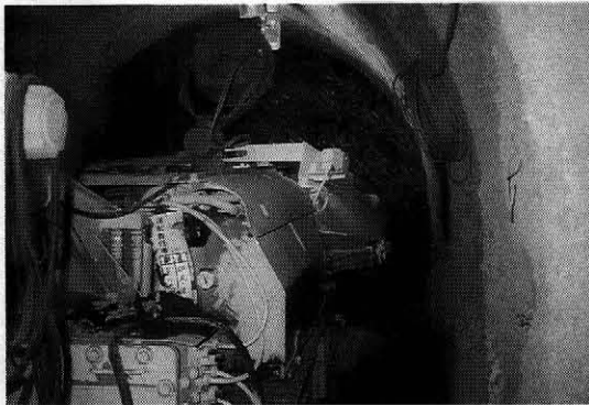
写真-4 掘削状況
