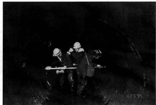
写真-3 管の変形量の測定状況
