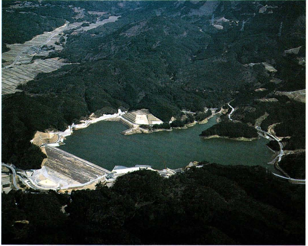
完成した蔵王ダム
