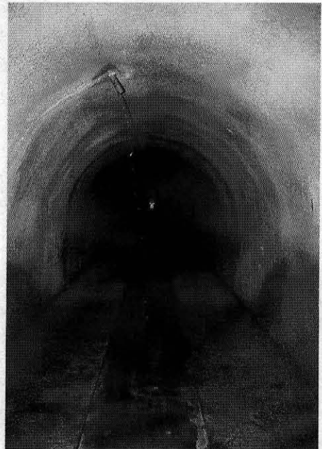
写真—7 水抜きボーリング
