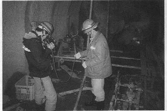
写真-3 先進ボーリングのガス測定
