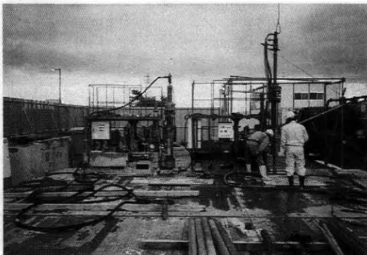
写真一七 CJG施工状況
