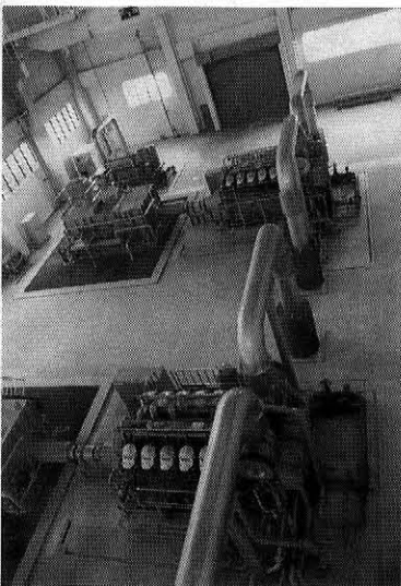
写真一 1 日光川排水機場
