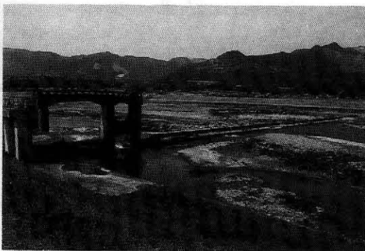
写真一 流出前の頭着工
