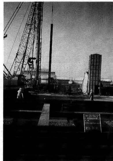
写真一 6 応力材建込み状況
