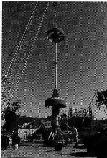
写真-2 リバース掘削機
