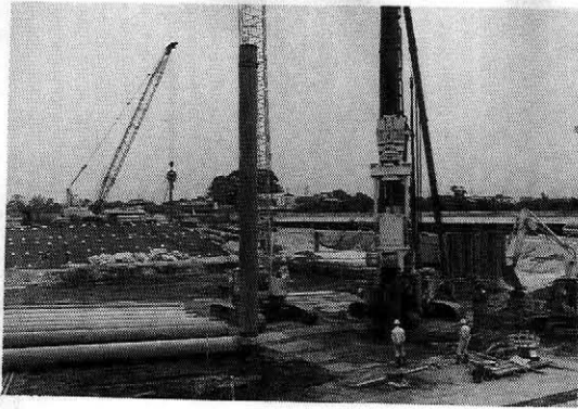
写真一 2 中掘式杭打機施工状況
