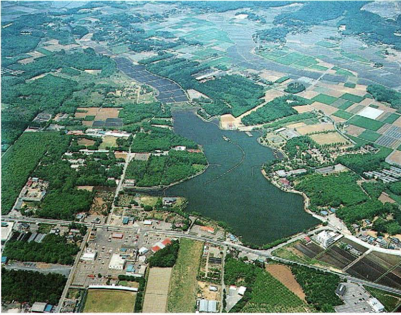
浚渫中の上野調整池 (本文18頁参照)
