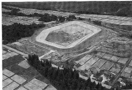
写真-2 盛立完了後
