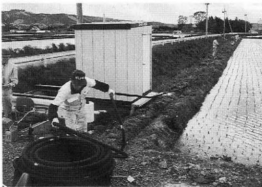
写真-5 コード埋設状況 (白い建物が操作室)
