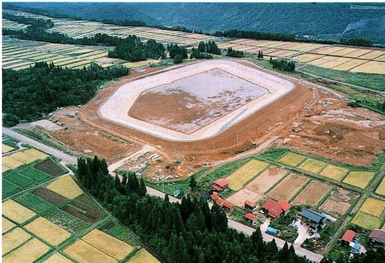
源内山調整池(上、着工前、 下、施工中) (本文27頁参照)
