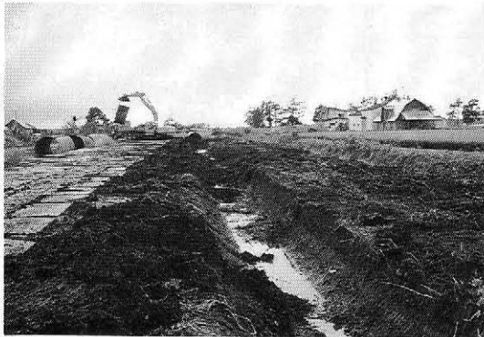
写真一 二 既設コルゲート管撤去状況
