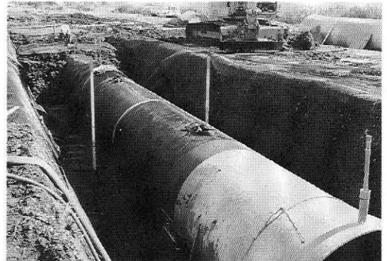
写真一五 シート布設及び埋戻し状況
