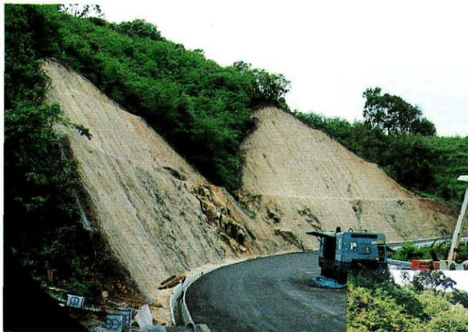
緑化工試験施工前(左)と 施工1年5ヶ月後(右)の状況 (本文13頁参照)
