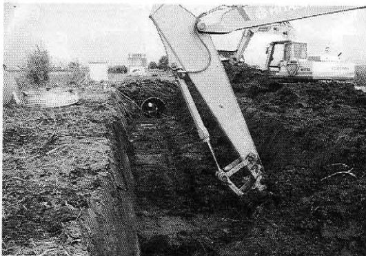
写真一 三 掘削状況
