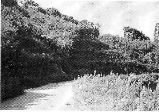
写真—3—2 施工1年5ヶ月後の状況
