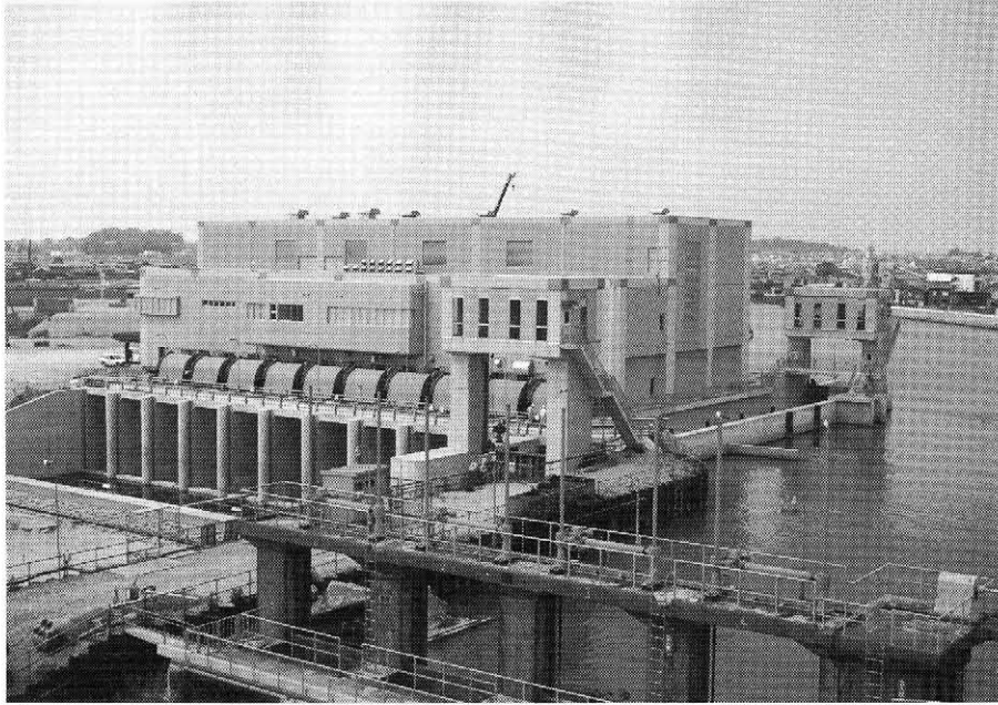
写真-1 完成近い新しい新井郷川排水機場 (手前は旧機場自然排水門)
