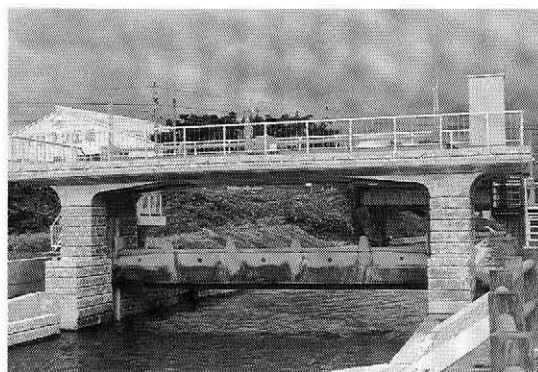
写真一 1 石積風に仕上げた取水堰堰柱
