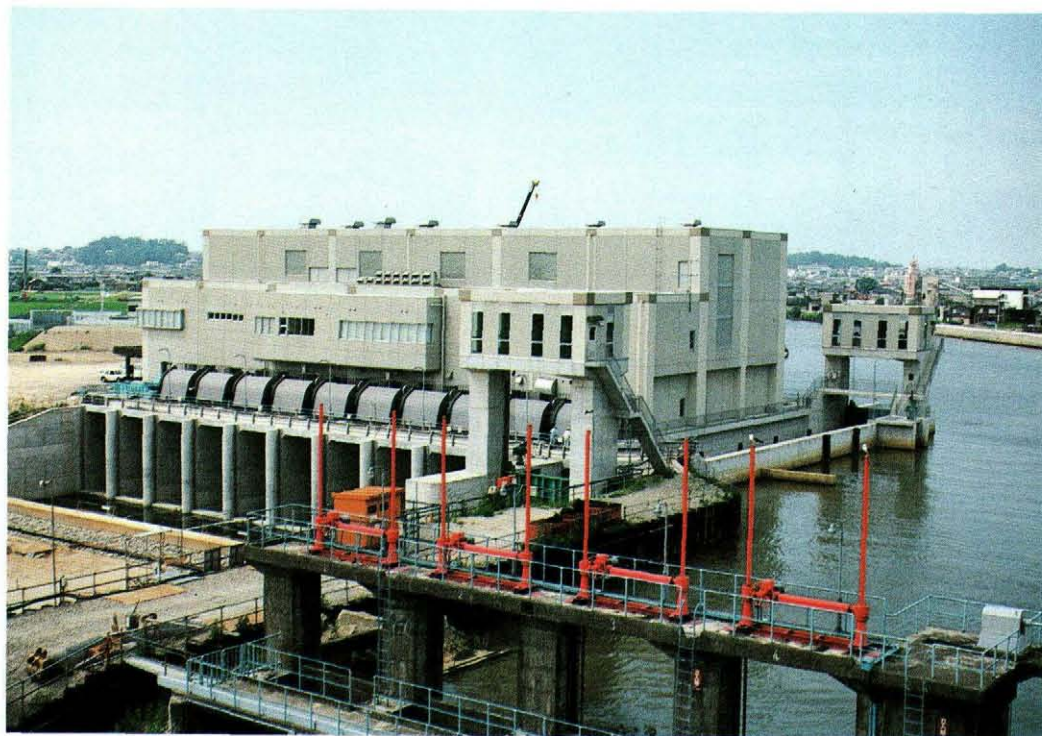
▲完成近い新しい新井郷川排水機場 (手前は旧機場自然排水門)
