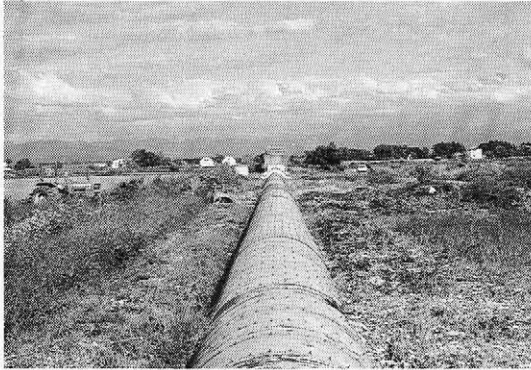
写真一 着工前（既設コルゲート管布設状況）
