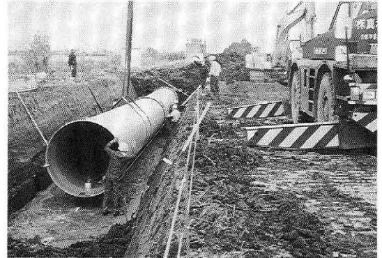
写真一四 管布設状況
