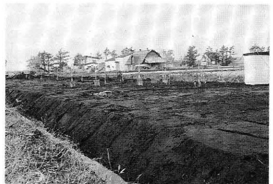
写真一 六 完了後
