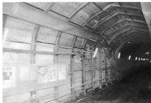
写真一四 支保工連込後の状況
