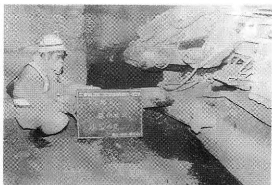
写真一二 ブームヘッダー前部に角材を用いて固定
