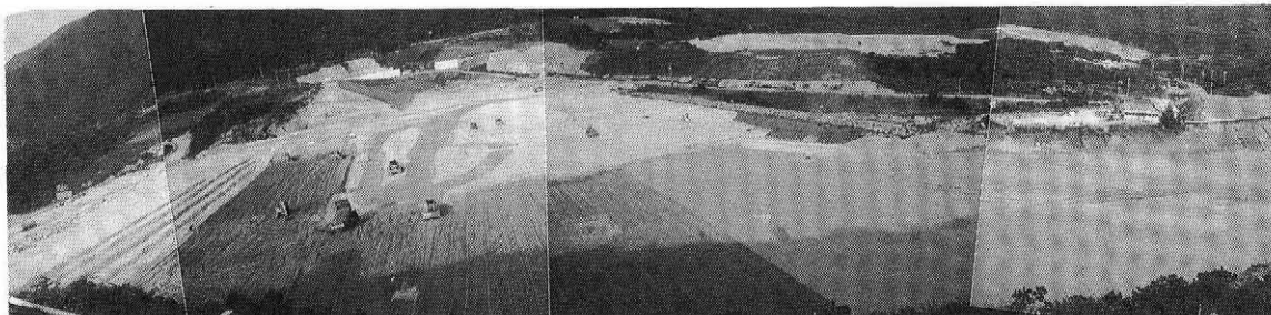
写真一 2 基礎処理工施工状況
