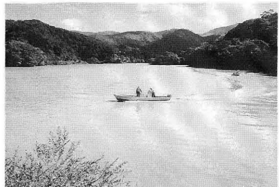
写真-3 無機凝集剤散布・攪拌状況
