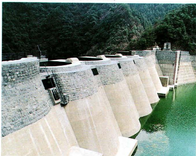
▼補修後の堤体全景 (前法面側)
