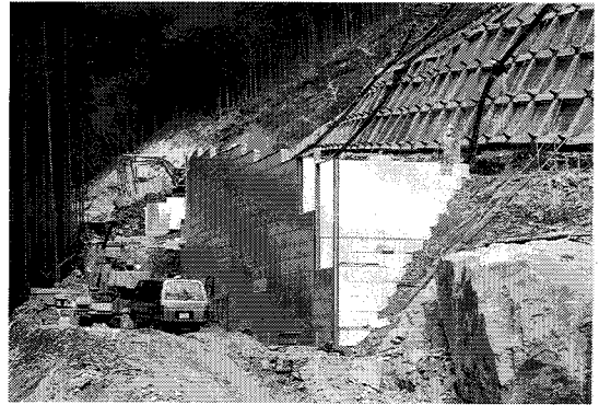
写真-3 EPS工法施工状況
