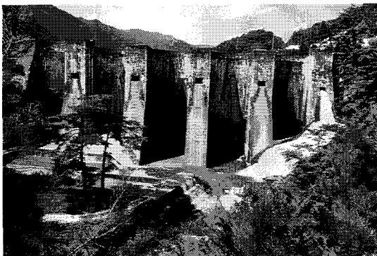
写真—1 豊稔池全景（補修前）
