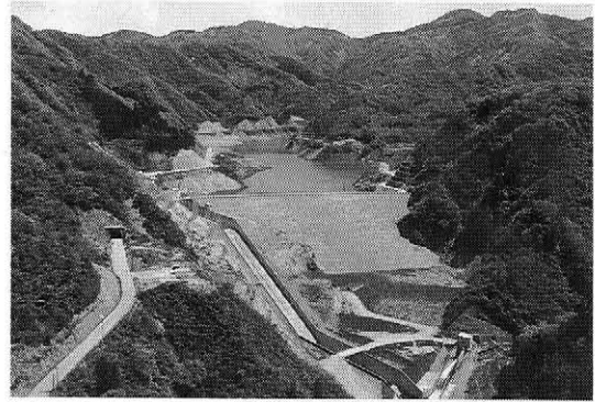
写真-2 白中ダム全景
