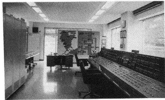
写真-3 新田原井堰操作室
