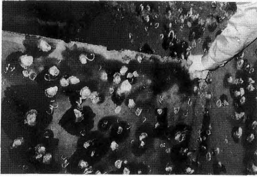
写真-5 ケーシング内部 (貝殻の付着状況)
