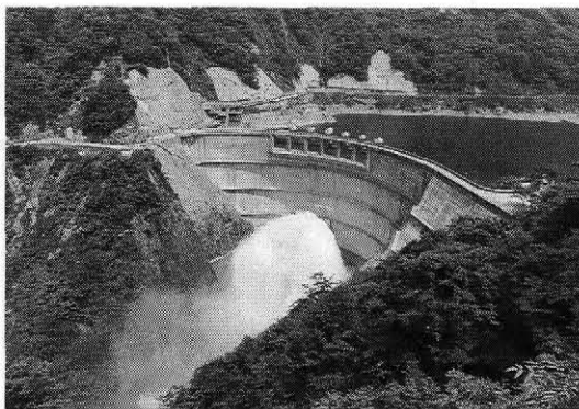
写真-1 刀利ダム全景
