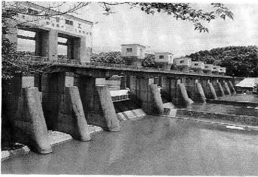
写真-1 明治用水頭首工の全景
