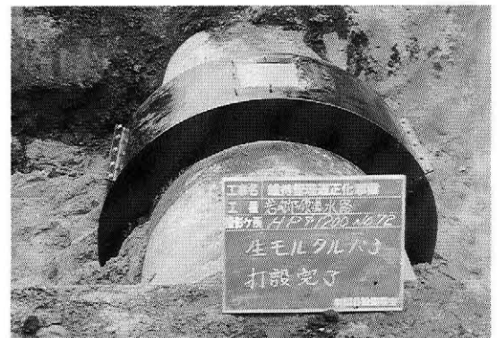
写真一2 同上 補修後 バンド工法
