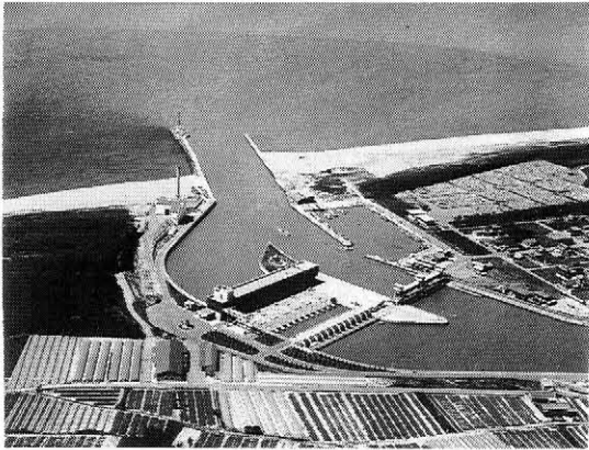
写真一 機場全景
