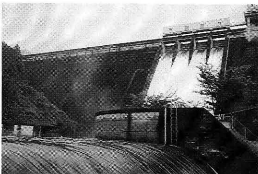
写真一 洪水放流中の津風呂ダム
