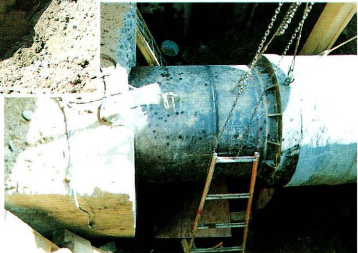
◀導水路の破裂状況と PC短管を鋼管に取り替えた補修▼
