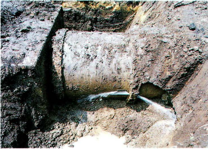
◀漏水状況と バンド工法による補修▼
