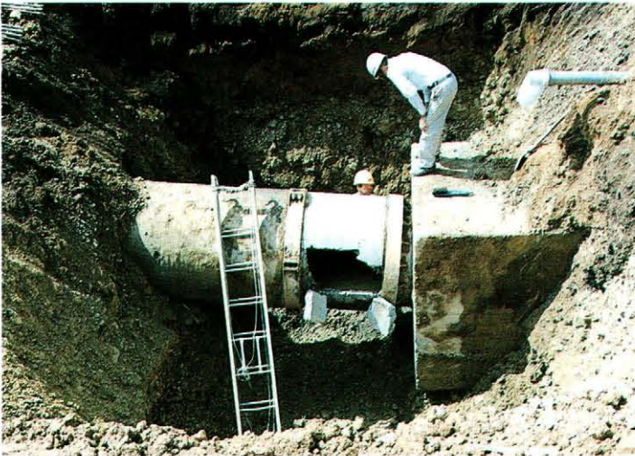
◀導水路の破裂状況と PC短管を鋼管に取り替えた補修▼
