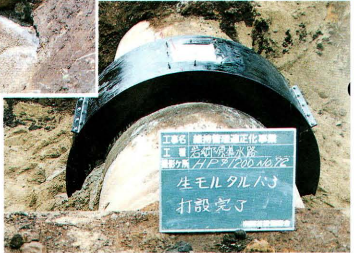
◀漏水状況と バンド工法による補修▼
