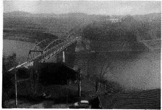
写真一 長柄調整池斜面保護工
