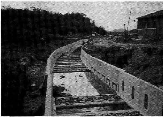
写真一 4 2号水路施工状況
