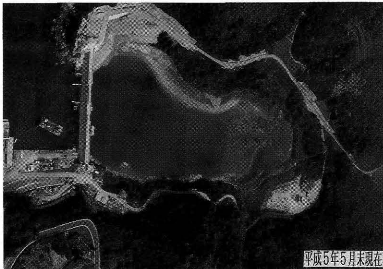
写真-1 鷹島ダム
