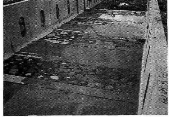
写真一 5 2号水路底面, 側面処理状況
