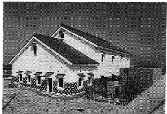
写真-1 七区排水機場
