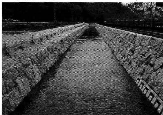
写真-1 1号水路A-A断面完成
