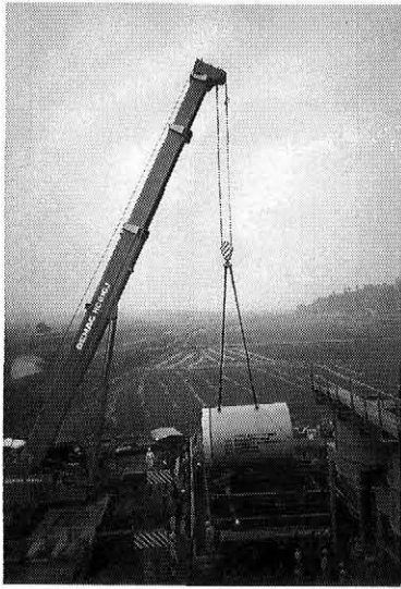
写真一2 シールド機搬入
