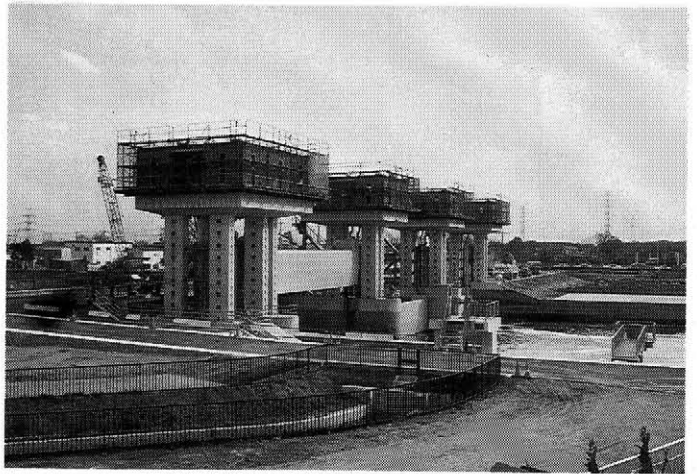
写真一 3 工事の進む末田須賀堰
