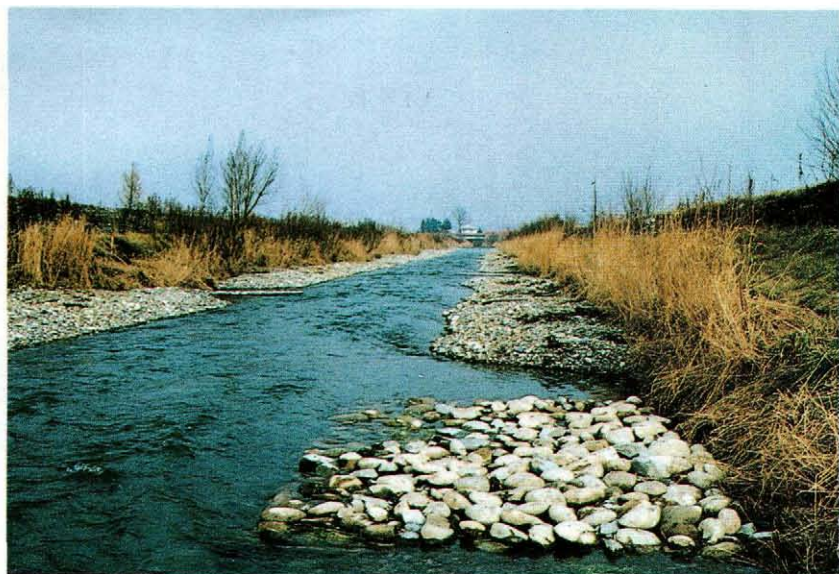
魚類生息環境づくりの ための試験施工例 (木砕玉石詰の魚巢沈床工) (本文18頁)
