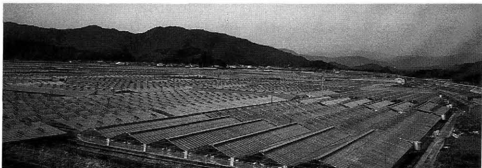
写真-2 排水機場屋上から地区南部全景
