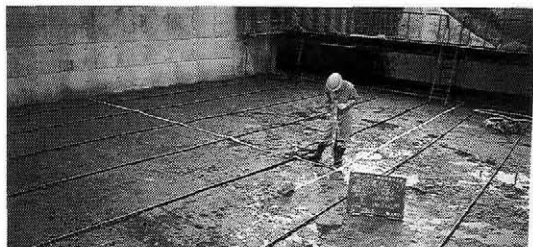
写真-4 クーリングパイプ布設状況
