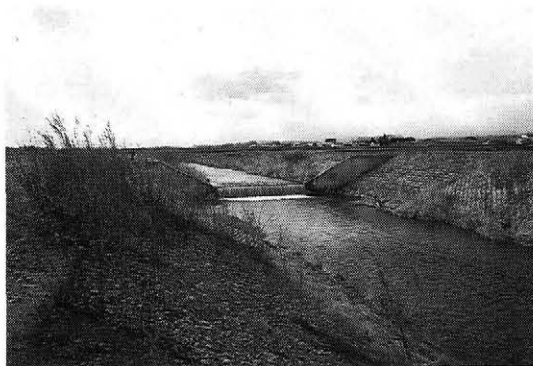
写真-5 床止工改良前
