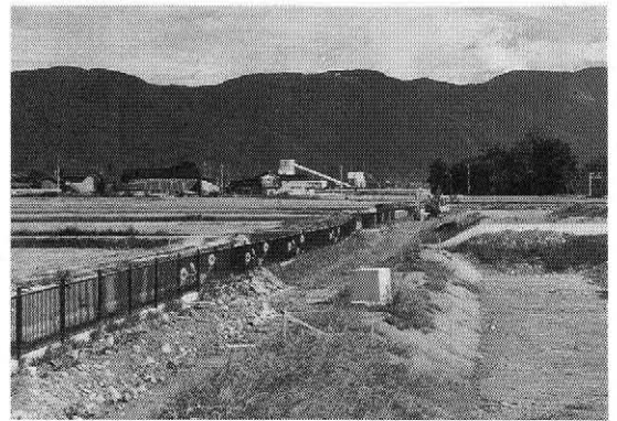
写真-2 朝顔デザインの転落防止柵 (暫定施工の管理道路側から撮影)
