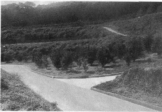
写真-3 水兼農道 平型水路取付部(大窪西地区)
