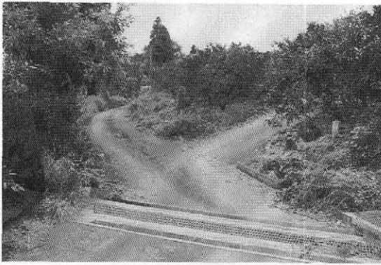
写真-4 排水及びゴミ対策(南山地区)
