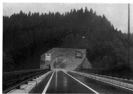
写真-4 胎内トンネルと炭鉱橋
