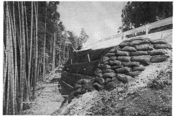
写真—3 盛土補強工法(施工後)
