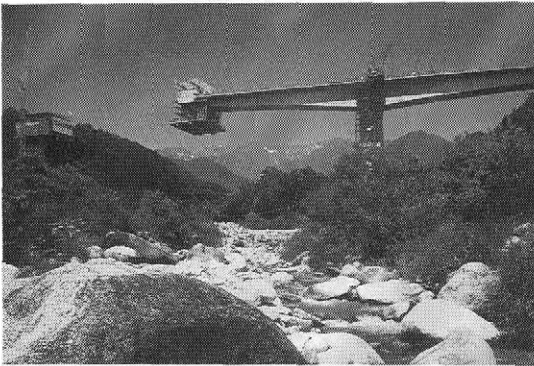
写真一4 中田切ふれあい橋架設状況 (平成4年7月現在の状況)
