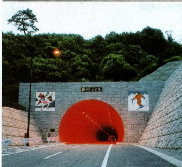
胎内トンネル（新発田市側坑門工）
