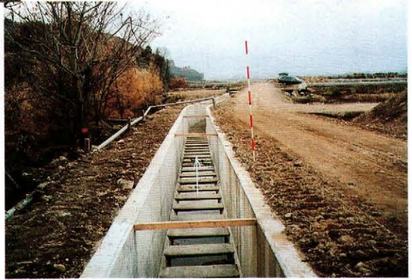
平成3年度施工2型水路
