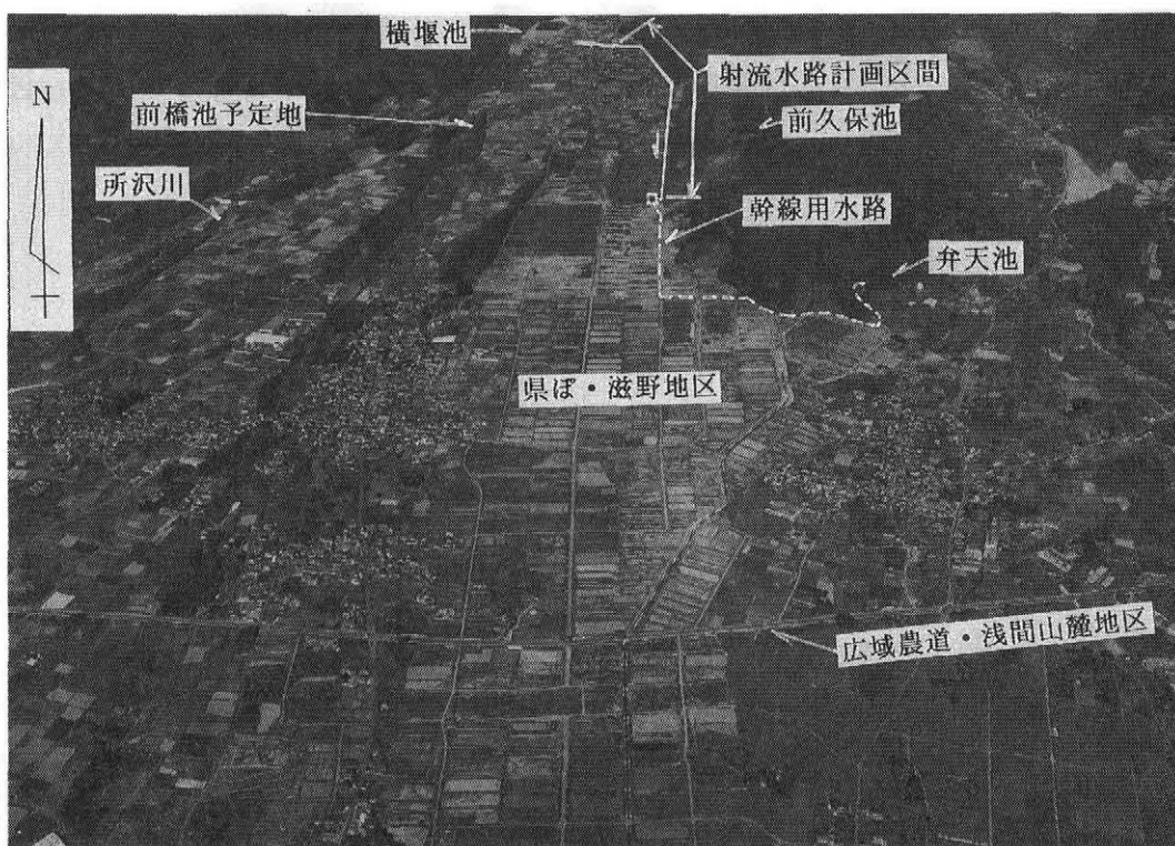
写真-1 横堰地区状況写真 (平成2年10月撮影)
