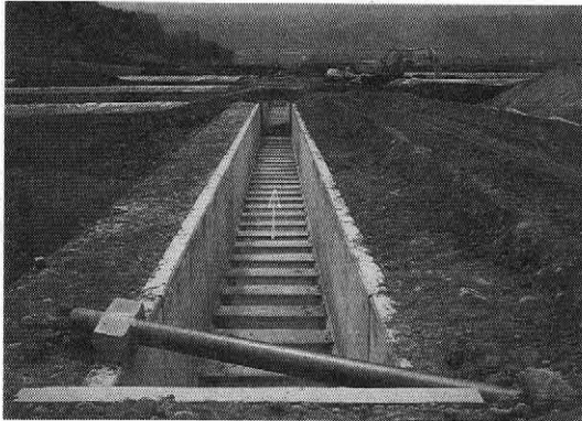
写真-2 平成2年度施工3型用水路(B=1.65m×H=1.65m) (平成3年2月撮影)
