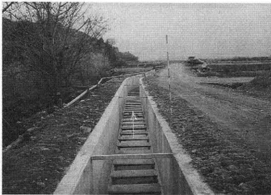
写真-3 平成3年度施工2型用水路(B=1.20m×H=1.40m) (平成3年11月撮影)
