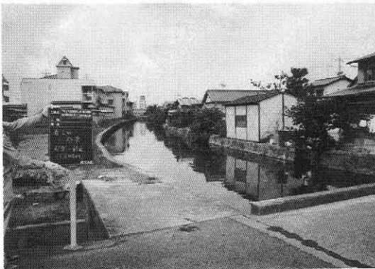
写真-1 下流から施工区間を望む
