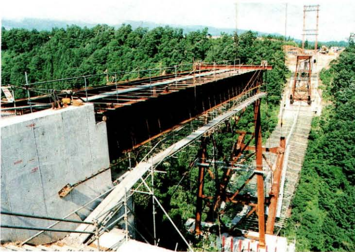
施工状況写真 (補剛桁の架設)
