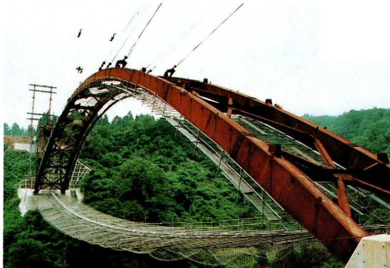
施工状況写真 (補剛桁の架設)
