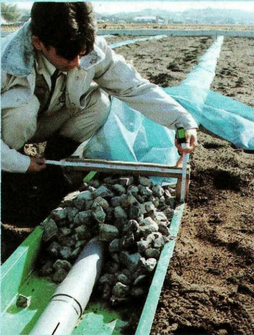
散水管施工状況
