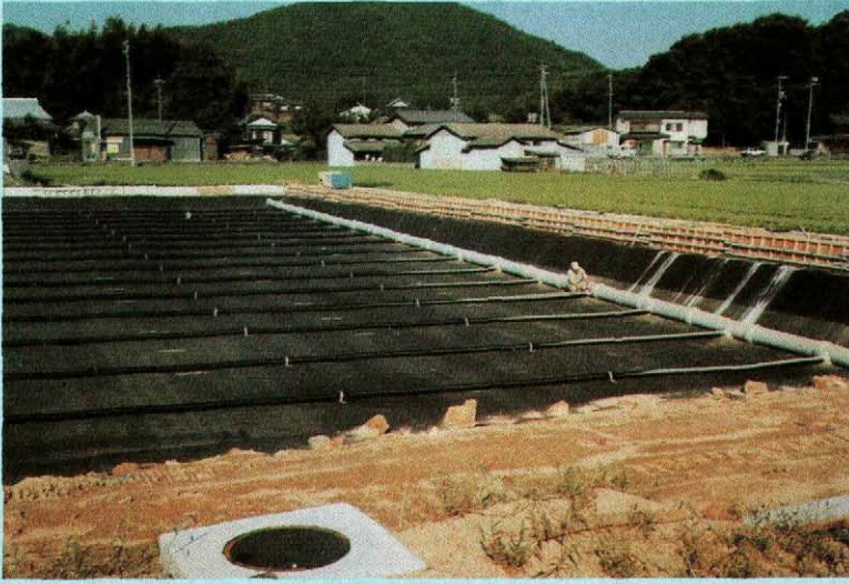
トレンチ下部集水管布設状況
