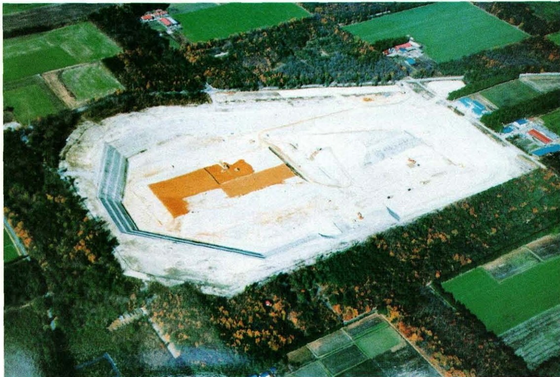
▲建設中の戸田調整池
