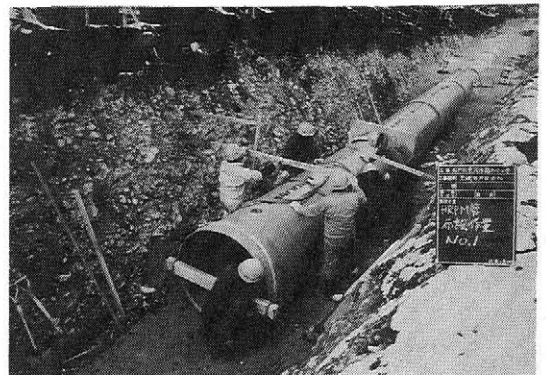
写真—4 FRPM水圧管路布設状況
