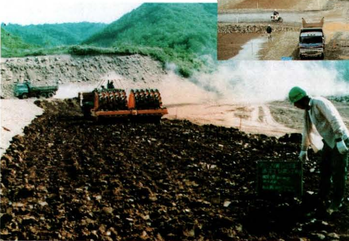
堤内ブランケット コア材盛立転圧状況
