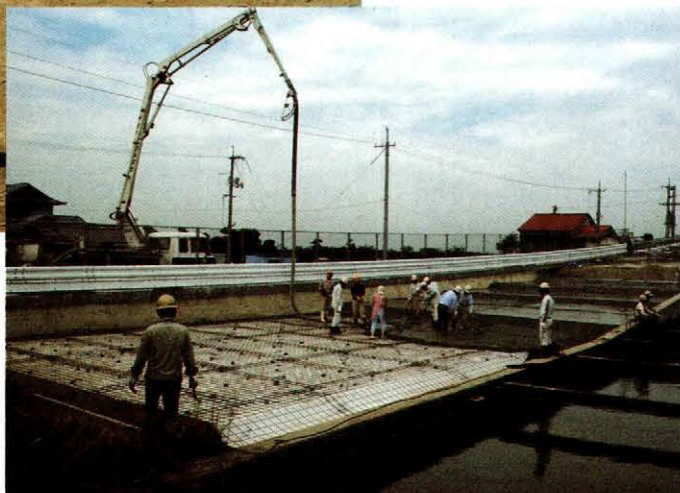
生コンの打設状況
