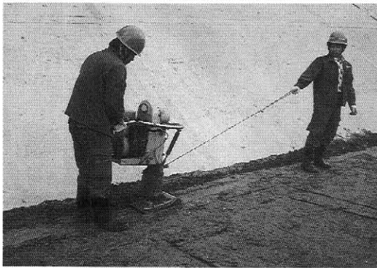
写真-1 コアゾーン左岸アバット部(置換コンクリート部) ブランケット盛立状況
