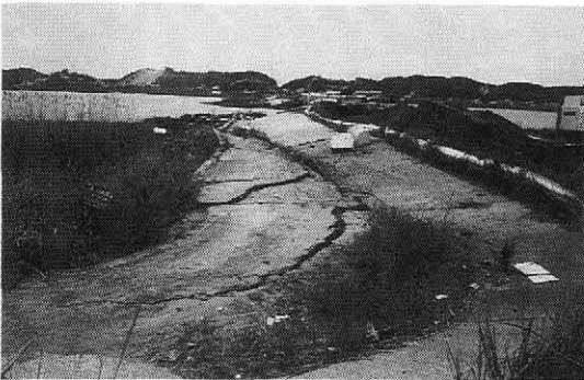
図-2 八郎潟干拓堤防の被害（日本海中部地震）
