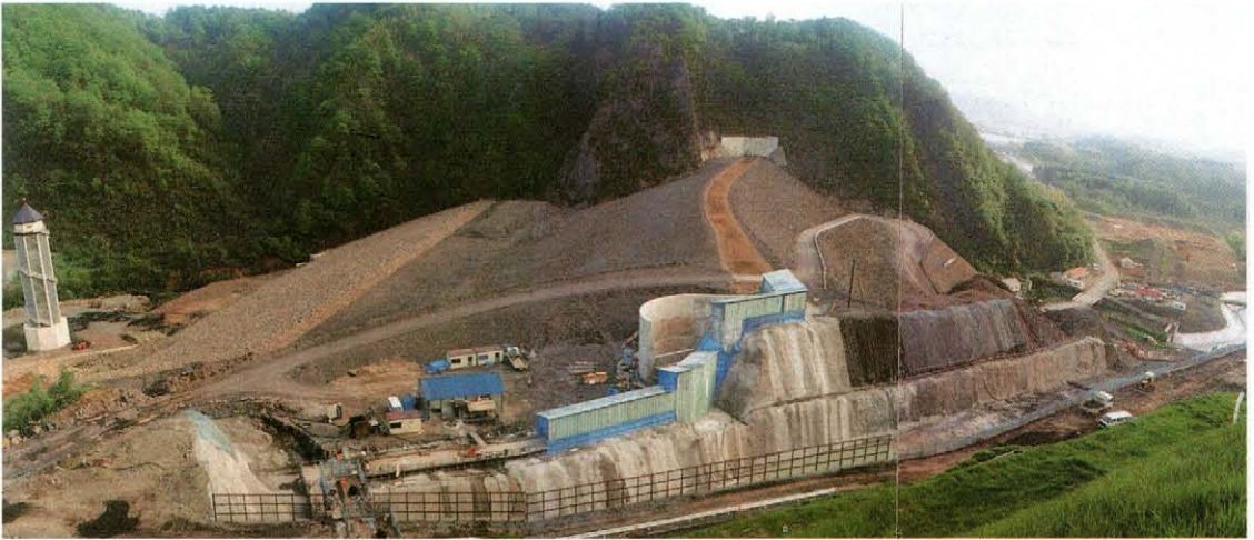
右岸地山から本堤、洪水吐、取水塔を望む
