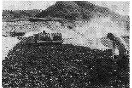
写真-2 堤体内ブランケットコア材盛立転圧状況
