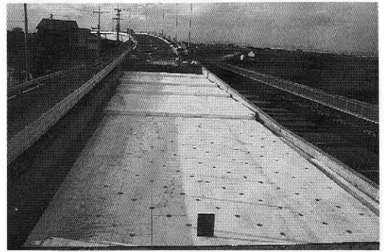
写真-5 EPSブロックの設置完了
