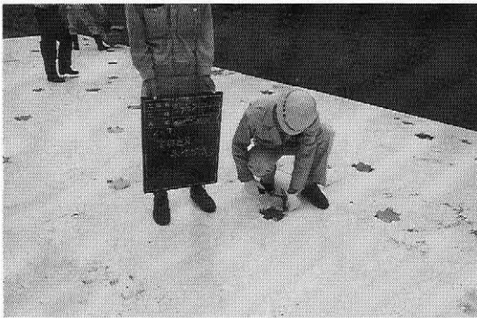
写真-4 緊結金具の設置状況
