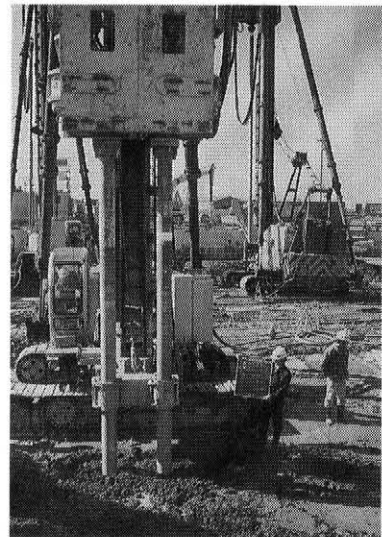
写真一八 施工状況・貫入攪拌（スラリー供給）
