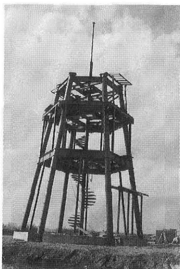
写真一3 風車工事中
