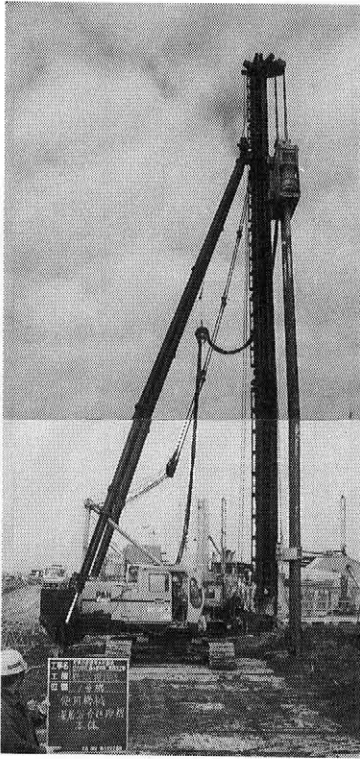
写真-2 深層混合処理機
