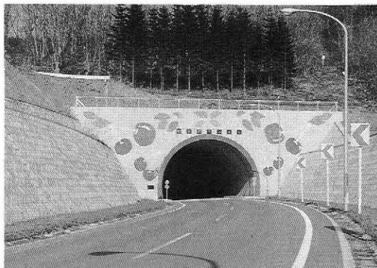
写真-1 トンネル坑門工
