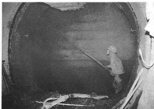
写真-1 吹付コンクリート施工状況
