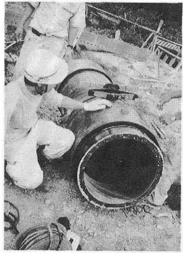
写真-1 調整管の現場製作…切断面の防蝕塗装
