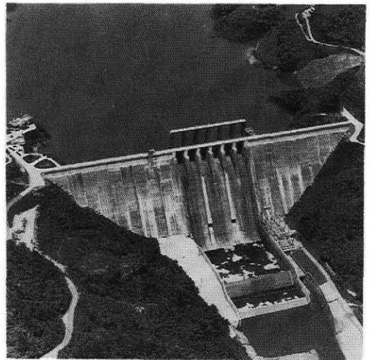
写真-1 早明浦ダム
