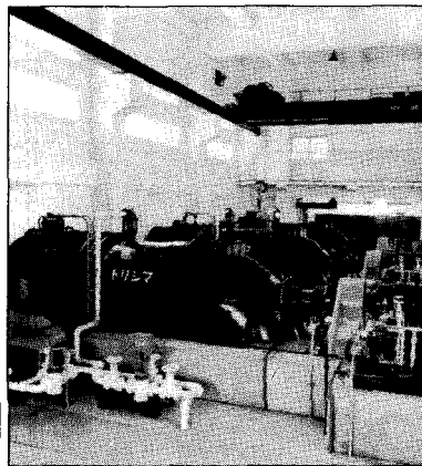
排水用横軸軸流ポンプ (千葉県殿 新堀川排水機場)
