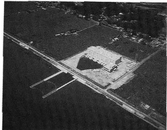
写真-3 霞ヶ浦用水機場全景
