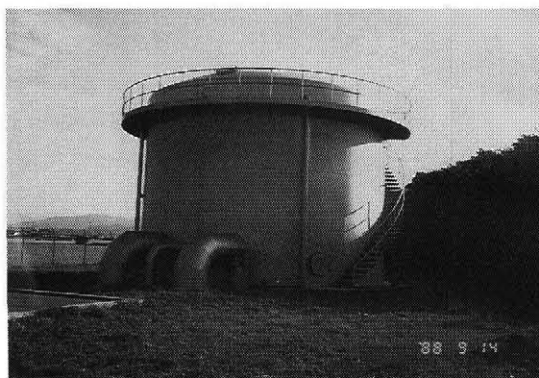
写真一 近畿農政局日野川用水農業水利事業所 鋼板製ワンウェイサイージタンク
