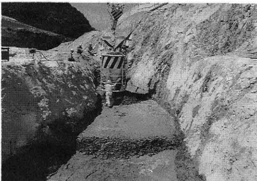
写真-3 断層処理プラグコンクリート打設状況
