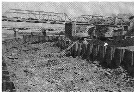
写真-2 仮締切施工状況
