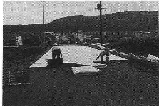
写真-6 断熱材敷設
