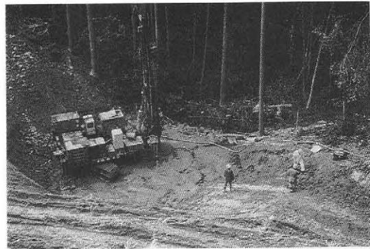
写真-1 地盤改良工(深層混合処理工実施中)
