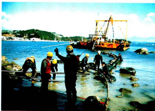
送水管陸揚作業(前島側)
