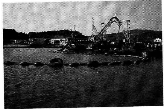
写真-9 パイプ浮場状況
