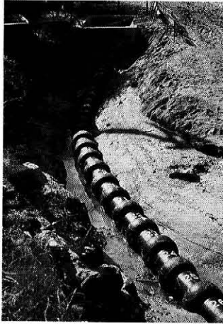
写真-11 防護管取付後
