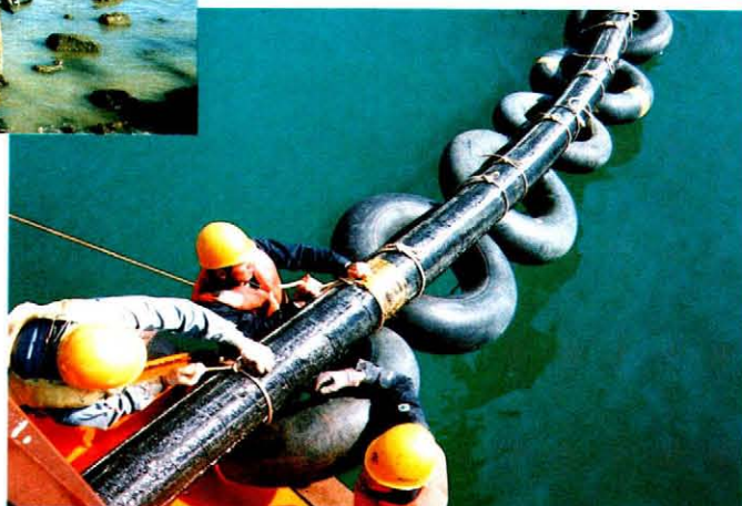
チューブブイ取付け作業
