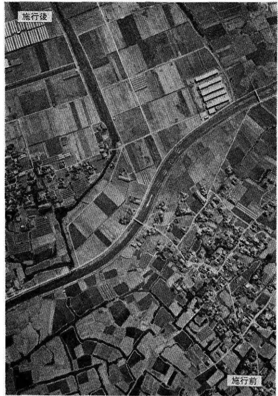
写真-2 ほ場整備施工前後(写真下部黒く連なったのがクレーク)
