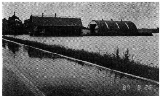
写真—3 昭和62年8月26日災家屋浸水状況 (恵庭市の農家)
