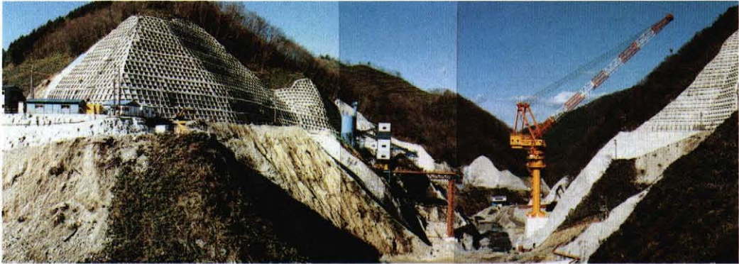
写真-2 坂根ダム（上流より、左に見えるのが左岸高標高部斜面保護工）
