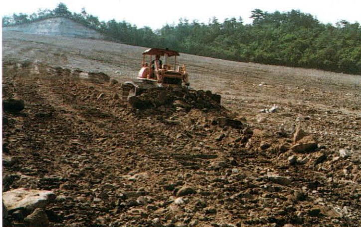
② 風化工程完了 (二次造成着手前)
