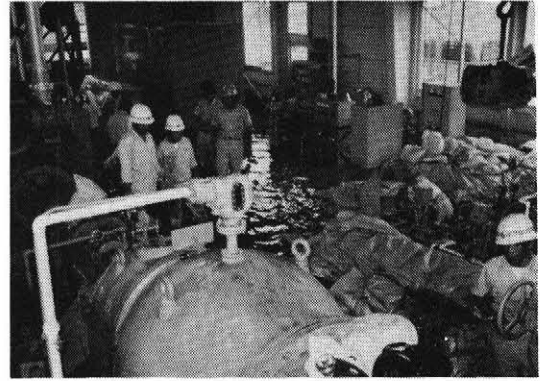
不来内機場内冠水状況
