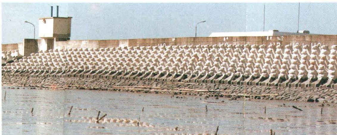
④ 復旧後の堤防
