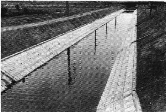
排水路の復旧後
