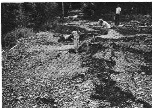
地すべり亀裂
