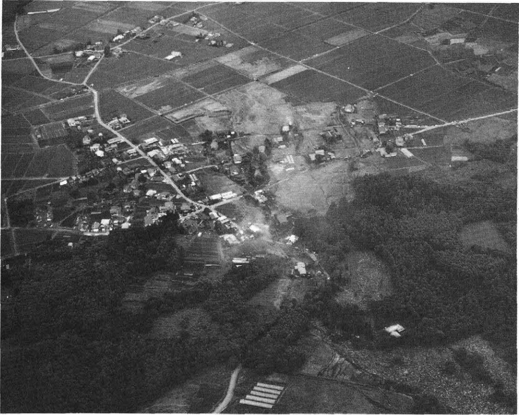
被災状況 ×60災（長野県信濃町板橋地区）
