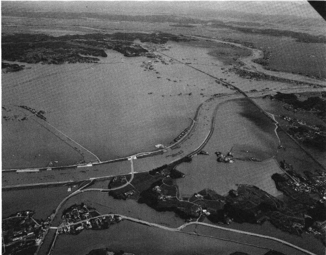
写真—1 宮城県鹿島台町で吉田川が決壊し濁水の海となった
