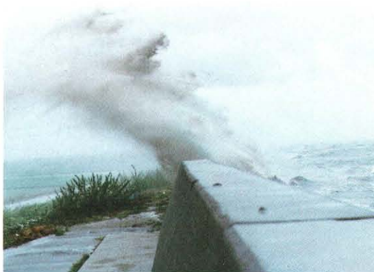
② 最大瞬間風速43.6m/sにより堤防に打上げる波高状況
