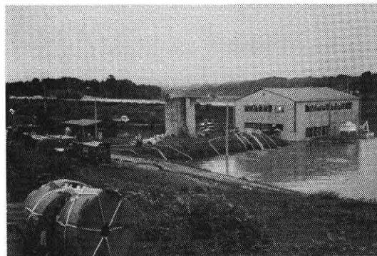
不来内機場内排水状況
