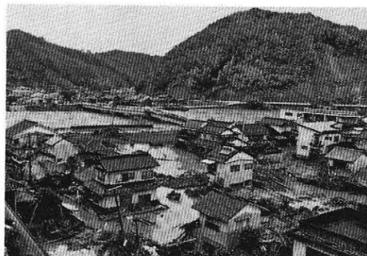
写真二 水の引いた後、残った家は流木とヘドロで復旧への道は険しかった。 (7月23日午前11時30分頃)(三隅)
