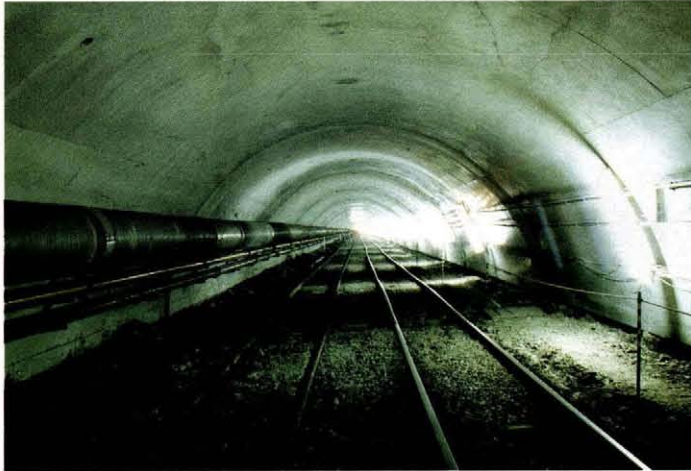
写真-3 上部半断面完成状況
