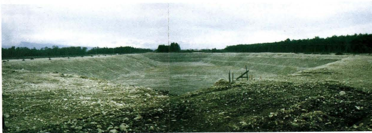
砂礫の先行掘削
