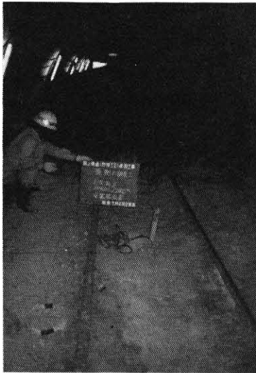
写真-5 弾性波探査（屈折波）
