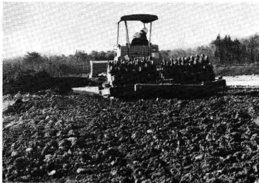
写真—3 タンピングローラー転圧(C材)
