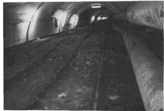
写真-4 盤膨れ箇所(1,675m附近)
