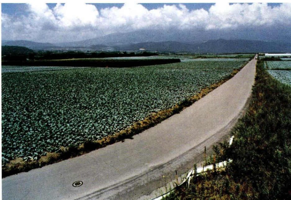
整備された農道とキャベツ団地(孺恋西部)
