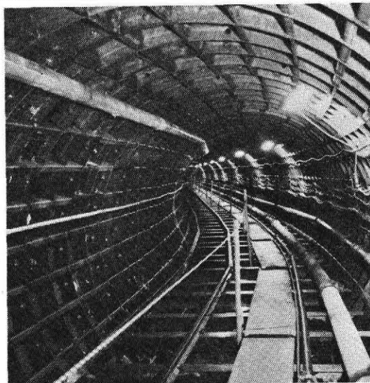
写真-2 一次覆工 (R=60)
