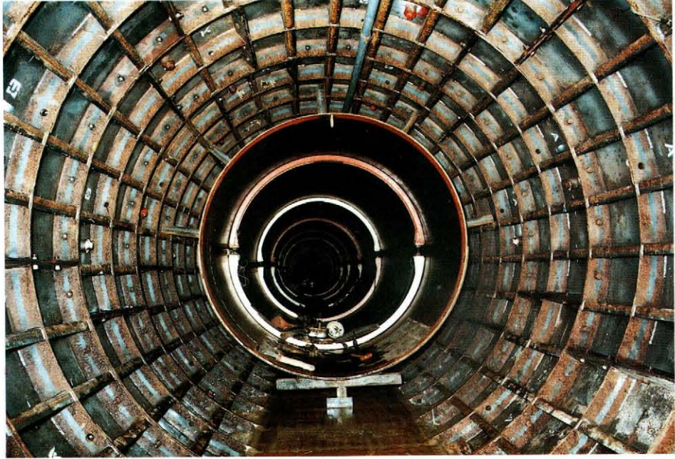
写真-3 二次覆工
