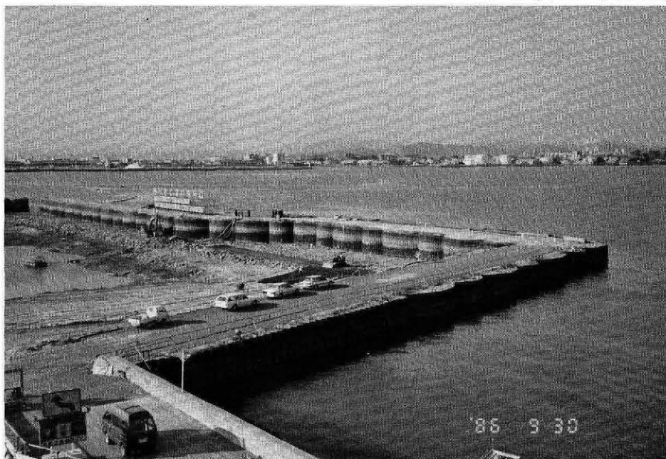
写真-3 現況写真
