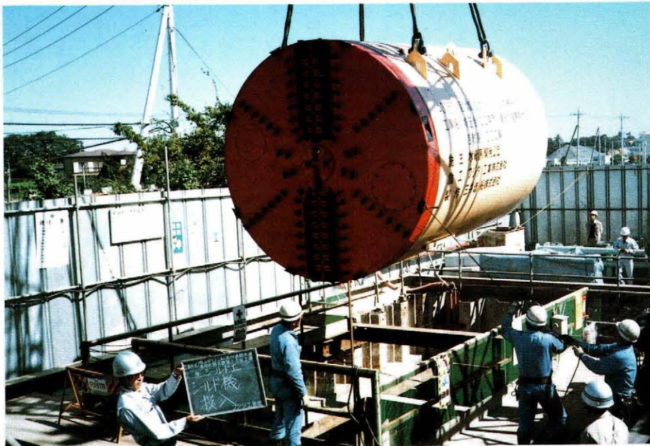
写真-5 シールド機投入
