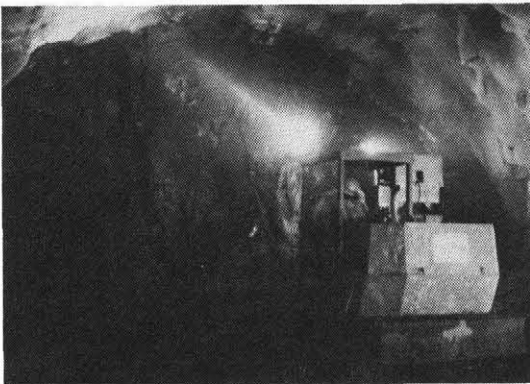
写真-1 吹付状況
