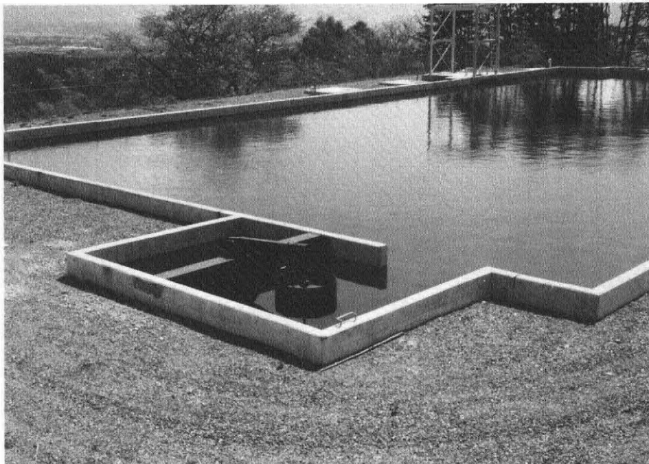
写真-1 下段南幹線3号ファームpond( V=6,150\text{ m}^3 )
