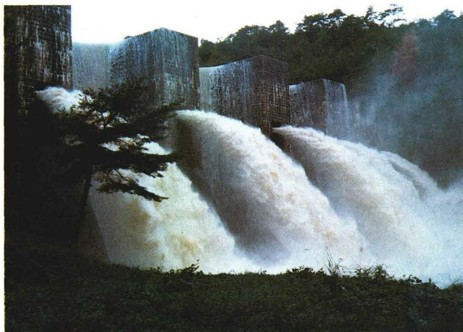
写真-3 サイホン洪水吐の放水状況
