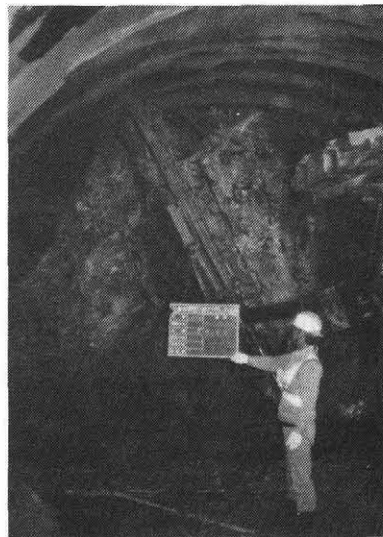
写真-3 ロックボルト削孔状況
