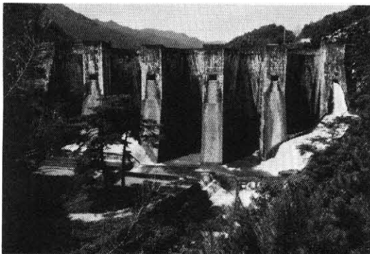
写真一 堤体下流面
